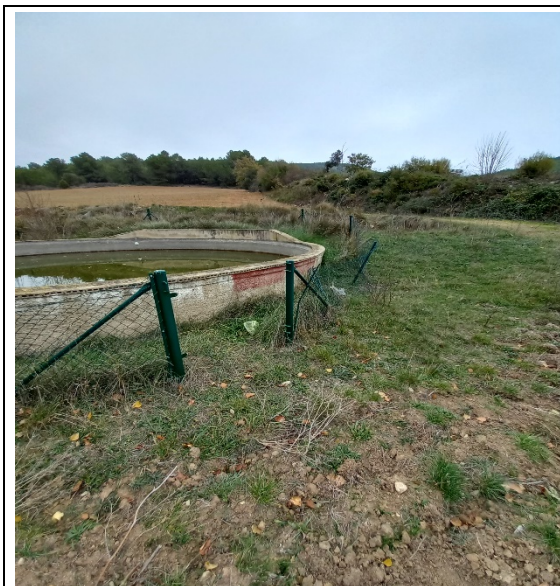
Figura 9. Estat punt d'aigua "Valldossera"
