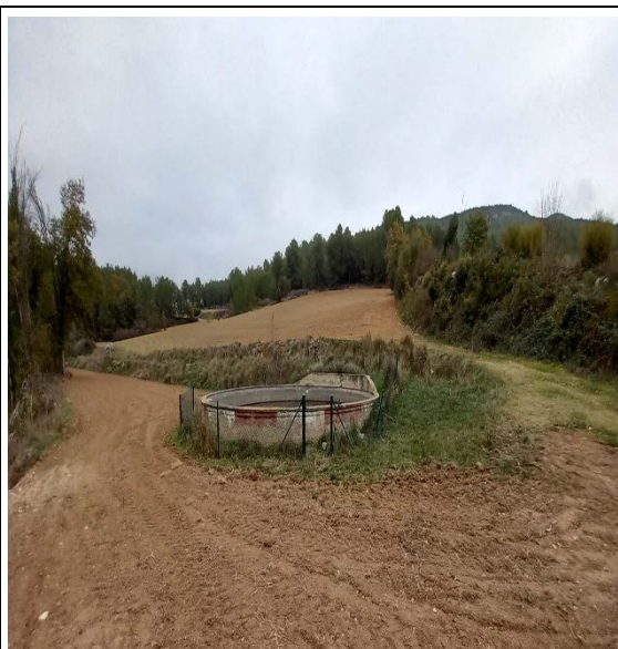
Figura 10. Estat punt d'aigua "Valldossera"
