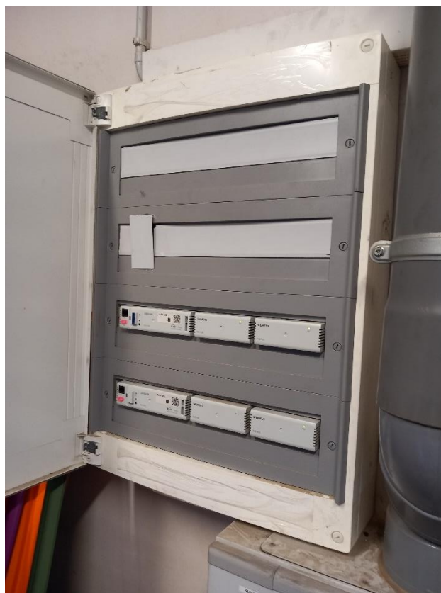
Foto 2: Armari de Control SYNCO de producció
