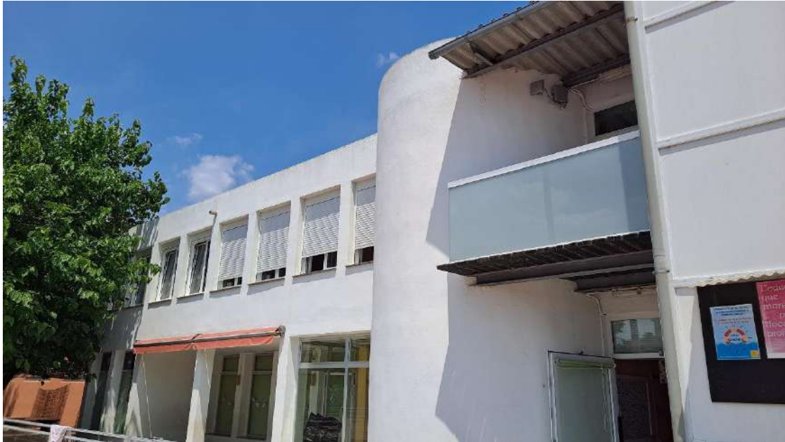
Fotografia façana zona intervenció
