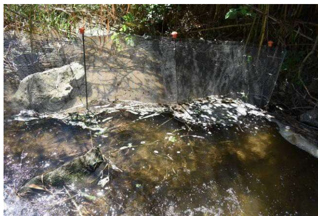
Figura 2 Exemples de col·locació de malla per a l'extracció d' Alternanthera . (imatges d'intervencions realitzades per Naturalea)
