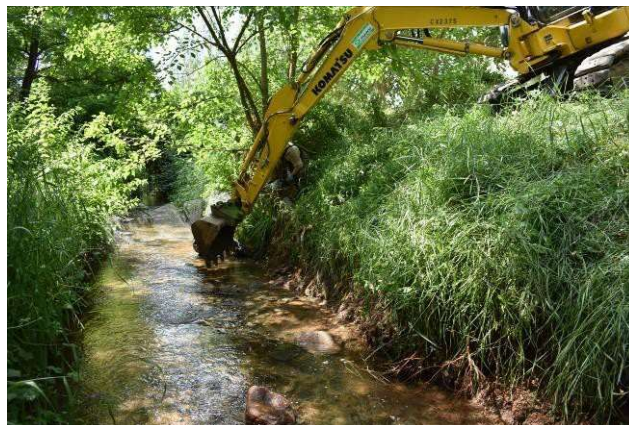
Figura 3 Exemples de retirada de sediments. (imatges d'intervencions realitzades per Naturalea)
