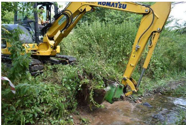
Figura 3 Exemples de retirada de sediments. (imatges d'intervencions realitzades per Naturalea)
