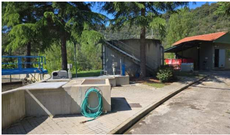
Arqueta sobrenedants espessidor i decantador
