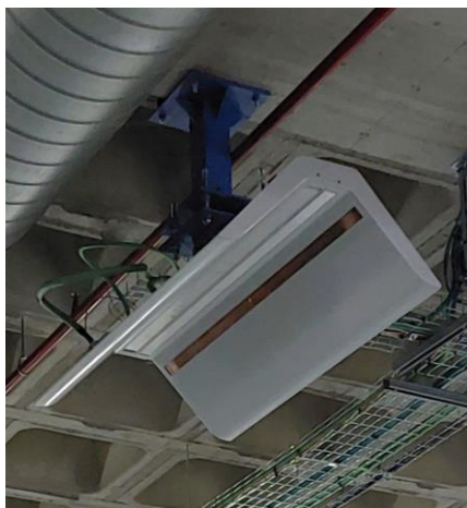
Figura 7. Detall ancoratge perfils i fixació campanes.
