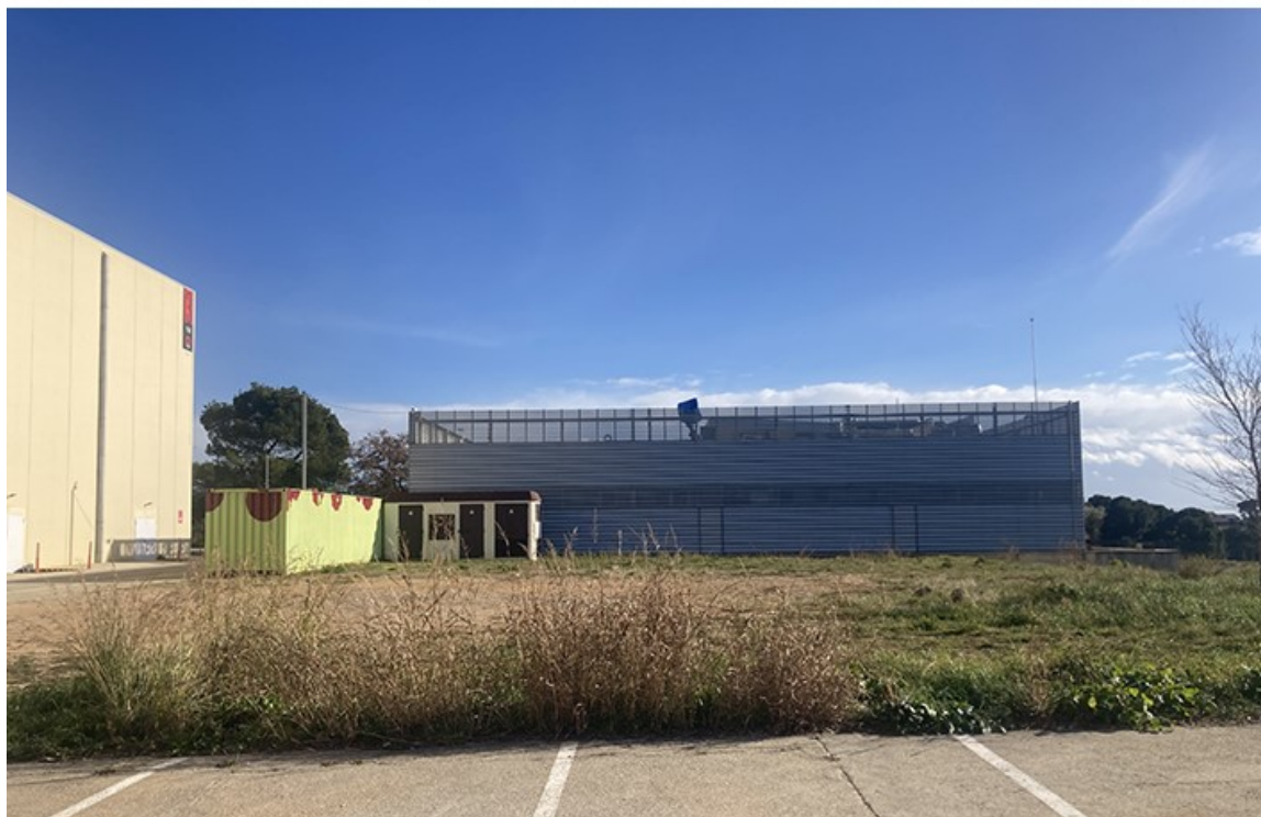
Fotografías del emplazamiento
