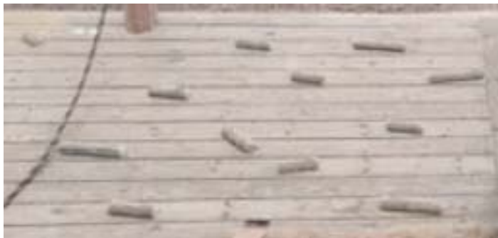
Exemple de paviment de fusta acabat
