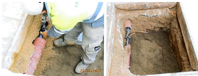
Croquis indicatiu de connexió de l'anell de degoteig a la canonada secundària per al reg de l'arbre
