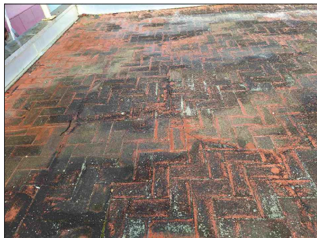
FOTO 5 - DETALL ESTAT COBERTES
