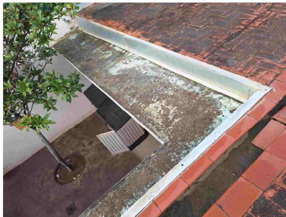
Detall remats existents
