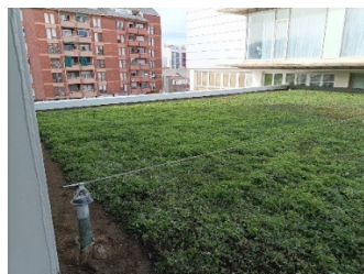
Sistemes de subjecció i seguretat per a treballs vinculats a línies de vida en cobertes Font: NTJ 11c
