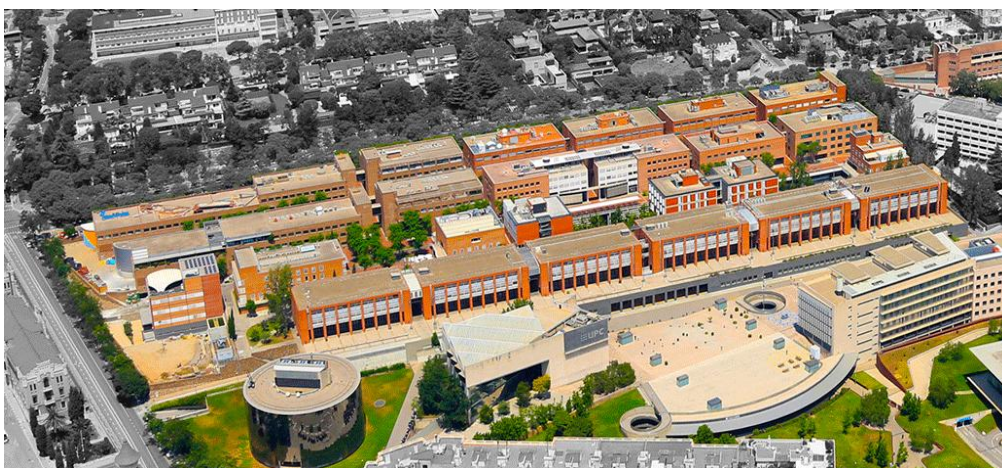
Vista aèria del Campus Diagonal Nord amb els edificis d'aularis DNA1-DNA6 al front.
