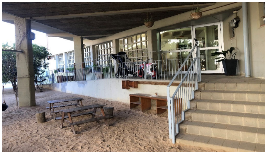
Entrada de l'escola, amb rampa i escales
