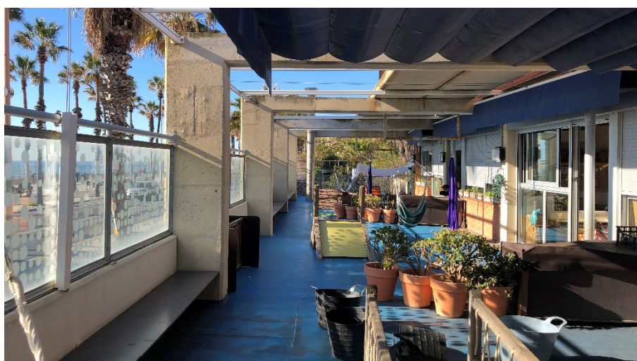
Terrassa amb ús de pati de jocs d'una de les aules, situada a planta primera
