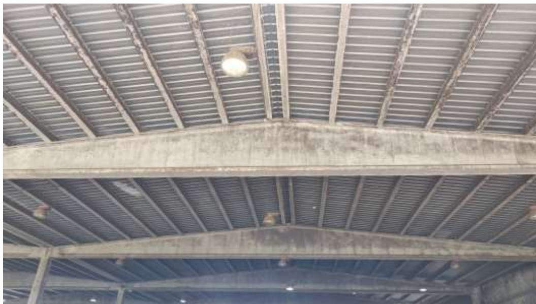
Figura 2. Estructura de suport de la coberta.
