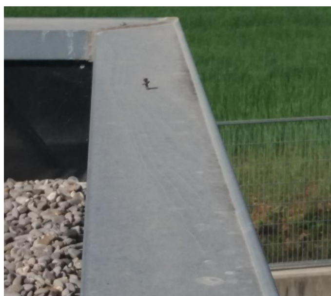
Foto 11: Detall de Remat de Coberta
