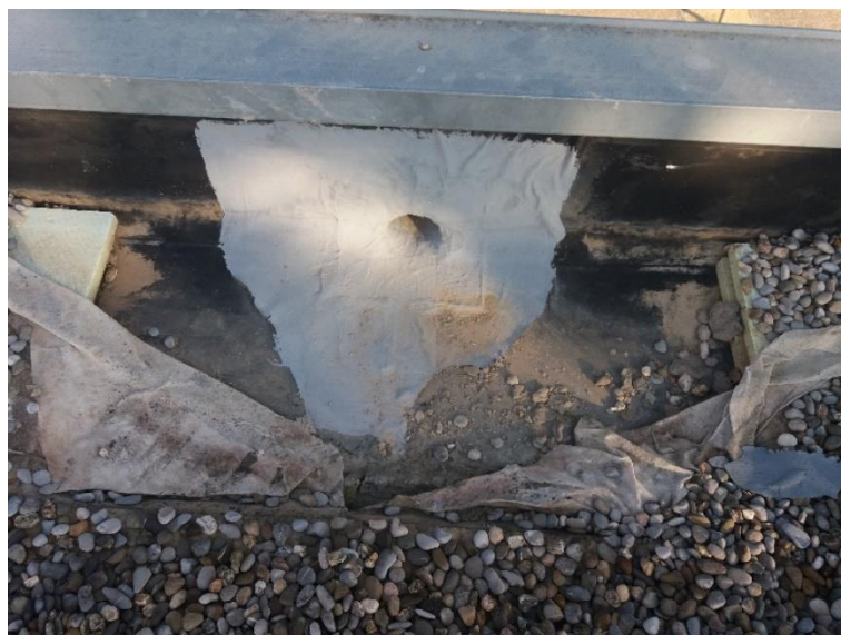
Imatge 2: Reparació embocadura EPDM a baixant.
