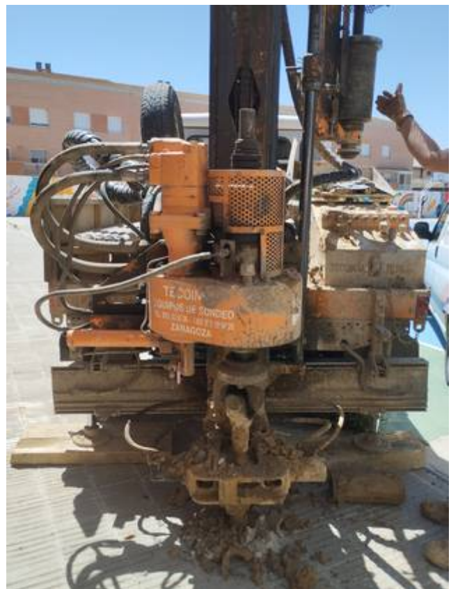
Vistes dels quatre sondeigs realitzats a la zona objecte d'estudi, S-1, S-2, S-3 i S-4 del tipus Rotació helicoïdal.
