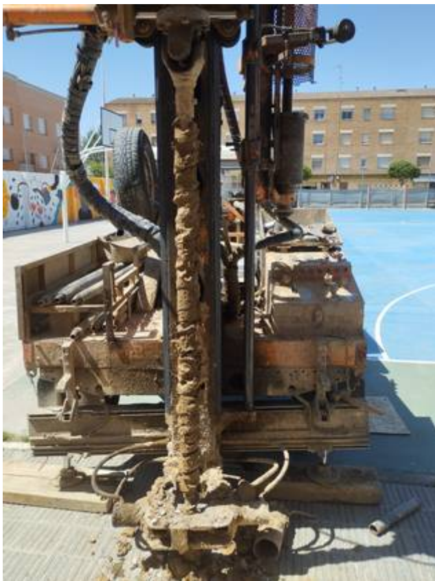
Vistes dels quatre sondeigs realitzats a la zona objecte d'estudi, S-1, S-2, S-3 i S-4 del tipus Rotació helicoïdal.
