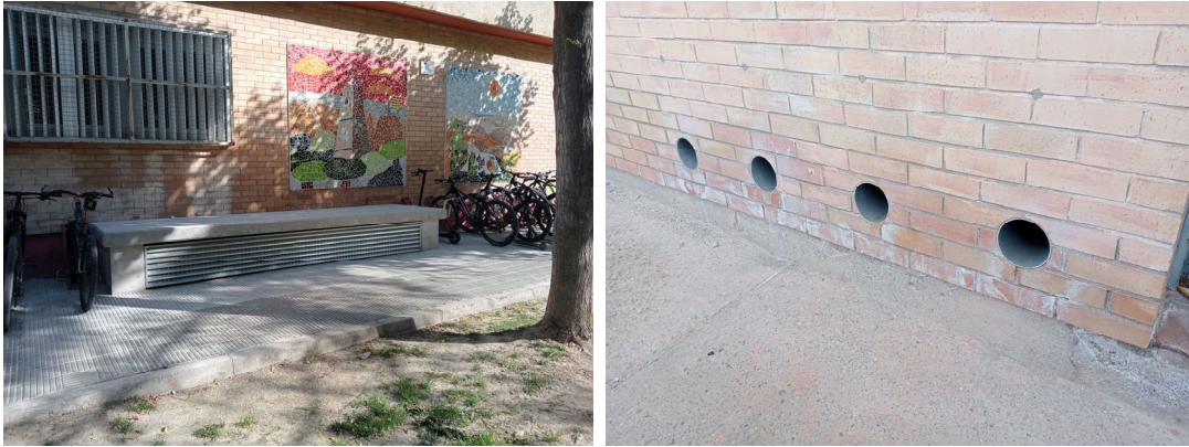
Imatge d'accés/ventilació i de ventilacions en mur/forjat executades en fase prèvia
