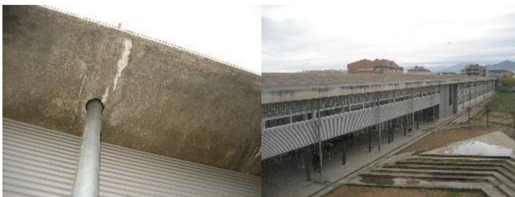
Fotografia: Part inferior de la canal i vista de conjunt.
