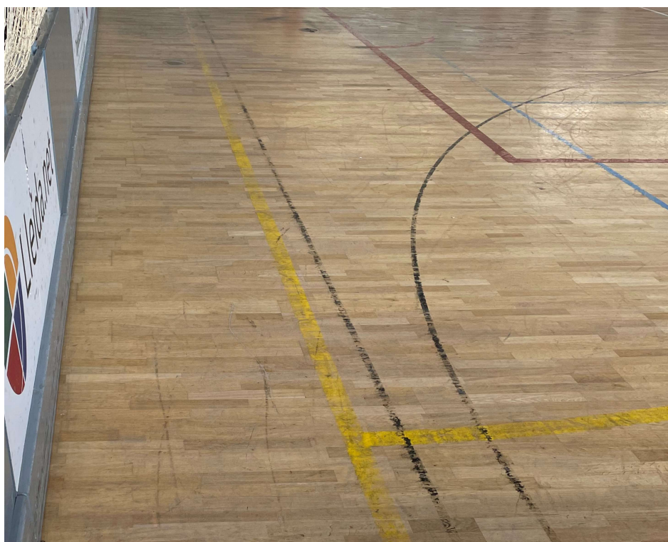
Estat actual del paviment
