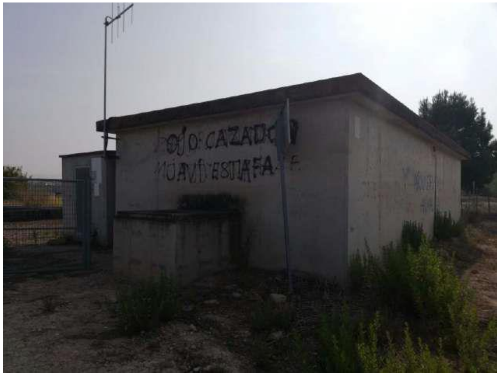
Figura 4. Vista general del dipòsit de la Mancomunitat
