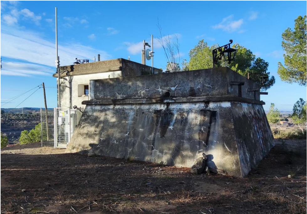
Figura 3. Vista general del dipòsit de reg i la seva caseta de cloració
