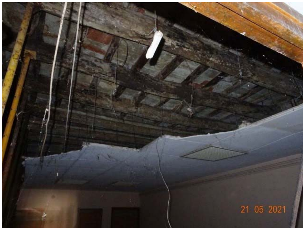
Foto 12- Interior Planta 1ª
