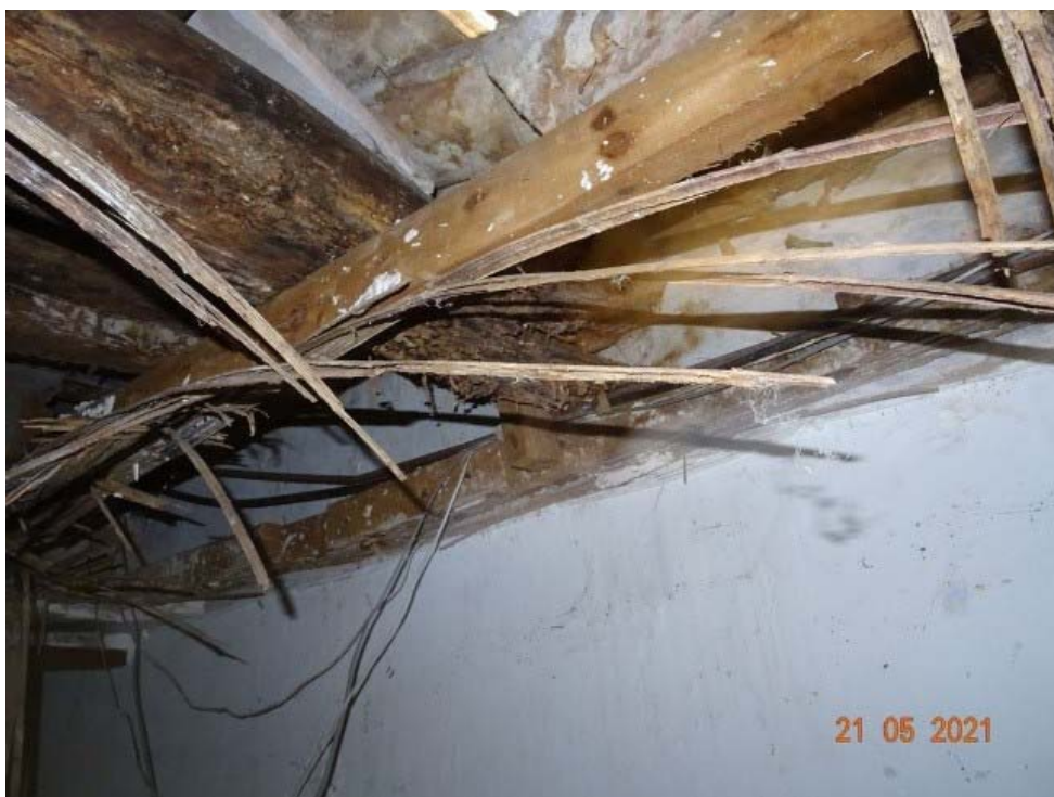
Foto 10- Interior Planta 1ª
