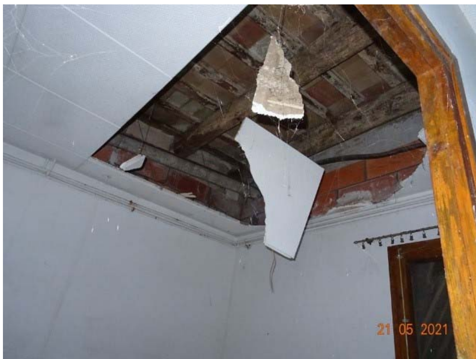
Foto 16- Interior Planta 1ª
