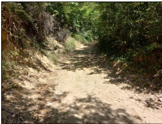
Imatge 1. Tram a millorar, amb forts pendents i sauló que de seguida s'aixaragalla, a part de presentar una secció encaixada en el terreny que fa que dificulti l'evacuació de les aigües en alguns trams.
