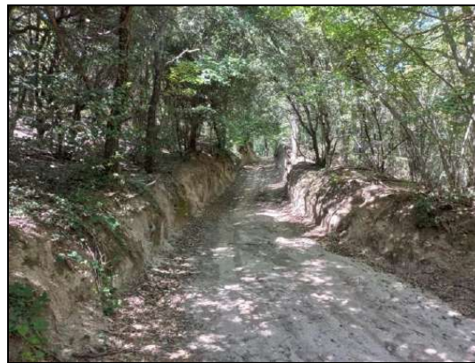
Imatge 1. Tram a millorar, amb forts pendents i sauló que de seguida s'aixaragalla, a part de presentar una secció encaixada en el terreny que fa que dificulti l'evacuació de les aigües en alguns trams.
