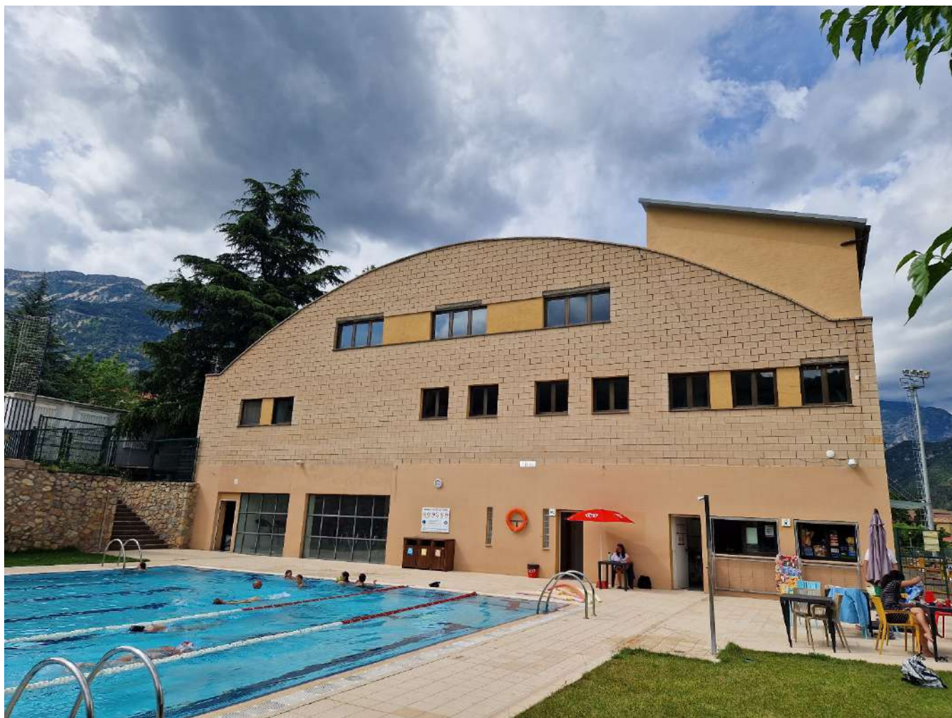
Imagen 12. Piscina de Sant Llorenç de Morunys i fachada de la pista cubierta sobre la que se colocaran las placas solares del nuevo sistema de generación térmica.
