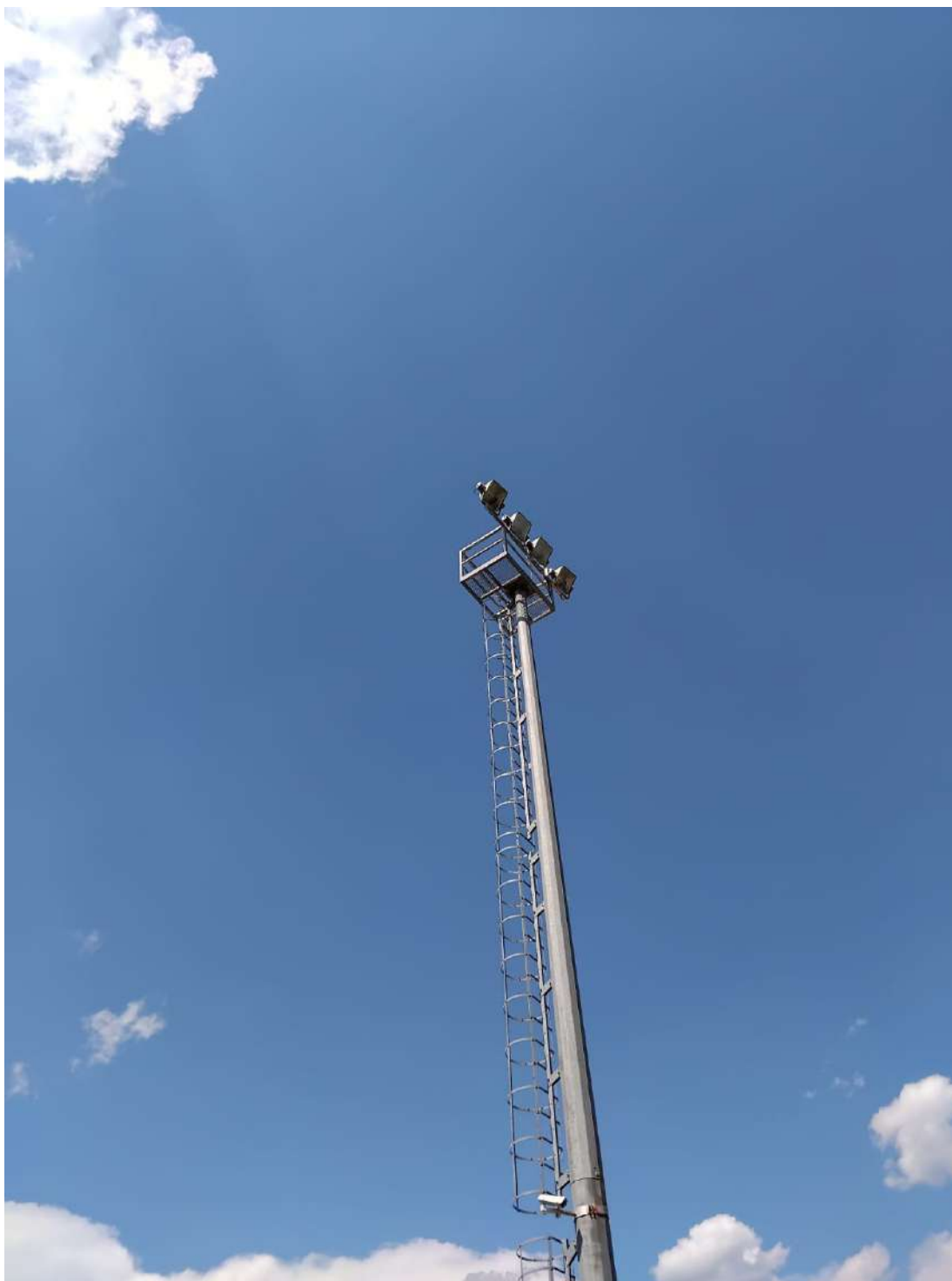
Imagen 6. Proyector de halogenuros sobre torre de 20m.
