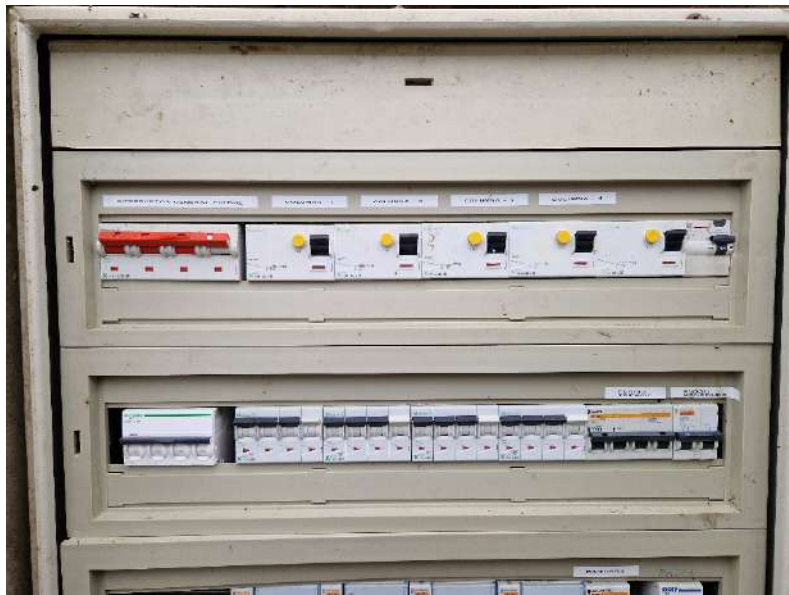
Imagen 1. Cuadro Q11 de control de las cuatro torres del campo de fútbol
