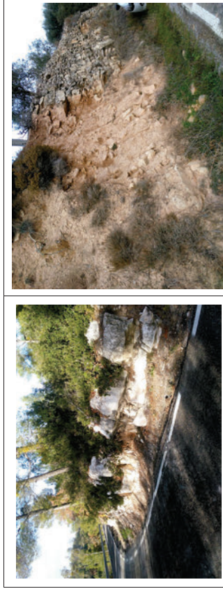
Talussos observats al llarg del traçat de la carretera. S'aprecia l'aspecte de la roca i inclinacions entorn 1H:3V/1H:4V i dipòsits quaternaris en coronació amb inclinacions més suaus.
