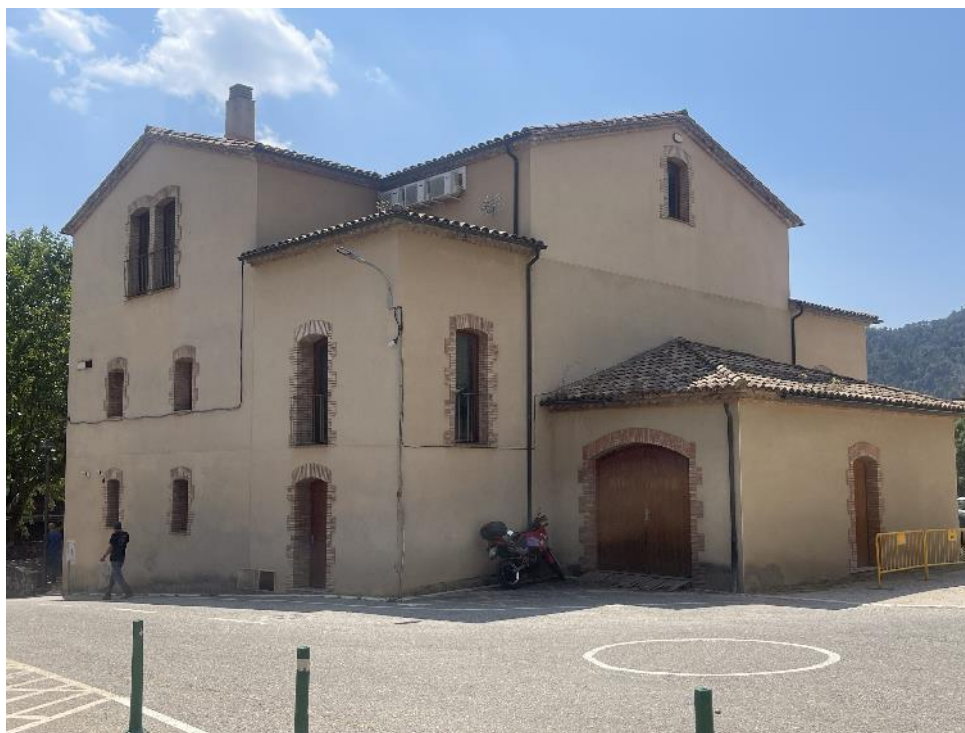
Fotografia 01. Vista general exterior de l'ajuntament de Sant Llorenç de Morunys
