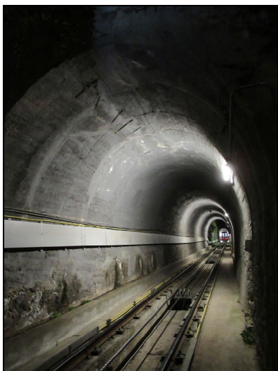
Foto 3: Secció túnel semicircular 2.
