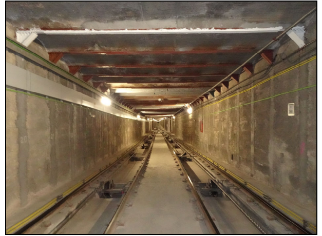
Foto 20: Secció túnel rectangular via doble.
