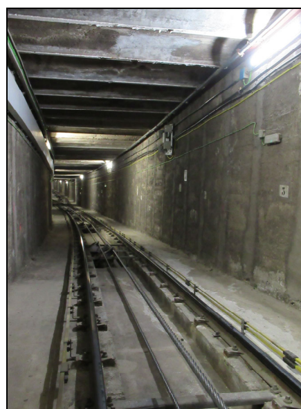
Foto 12: Secció túnel rectangular via única.
