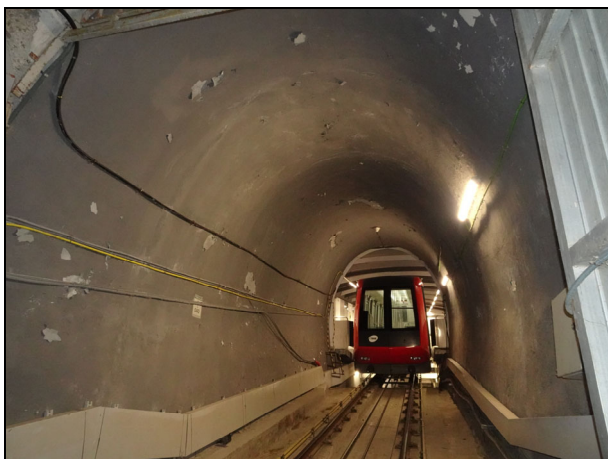
Foto 1: Secció túnel semicircular 1.
