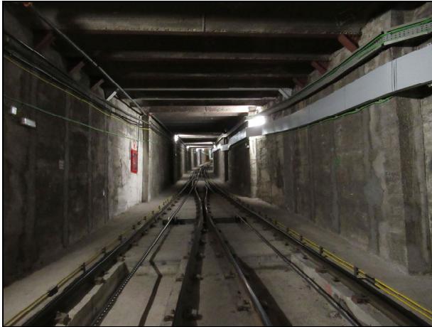
Foto 19: Secció túnel rectangular via doble.
