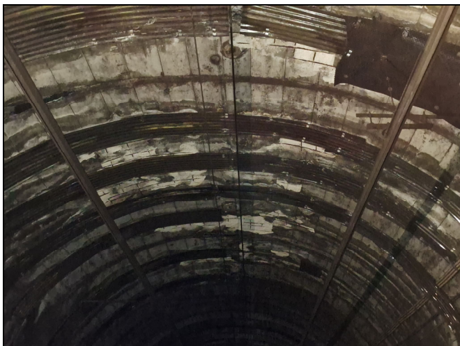
Foto 11: Detall d'armadures vistes a la volta.
