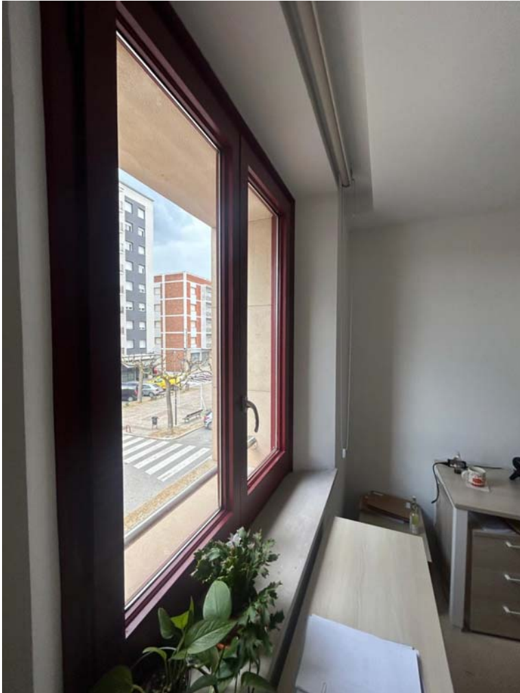
Planta primera Fotografia estat actual espai interior entre finestra i cel- ras existent.
