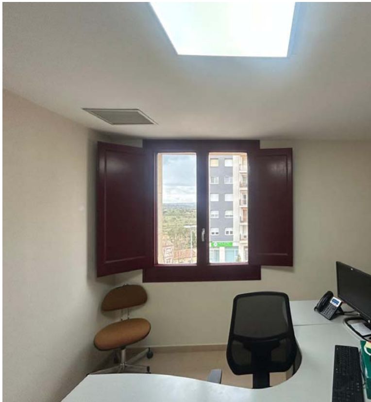
Planta segona Fotografia estat actual espai interior entre finestra i cel- ras existent.
