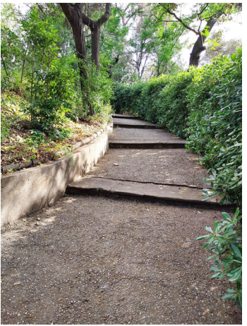
Foto S3-F3 Escales de pujada a la piscina on es veu, de fons, el túnel de mèlies
