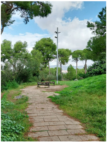
Foto C1-F5 Vandalització del mobiliari urbà.
