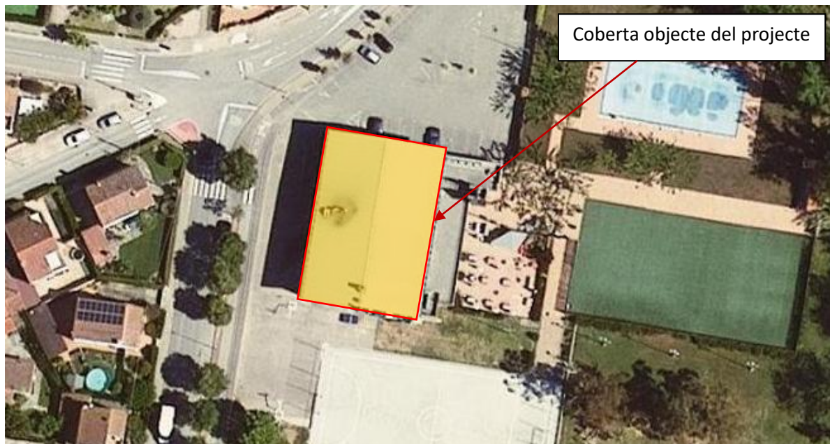
Figura 2. Emplaçament i accés a la coberta objecte del projecte. Font: lcgcat.cat i elaboració pròpia.
