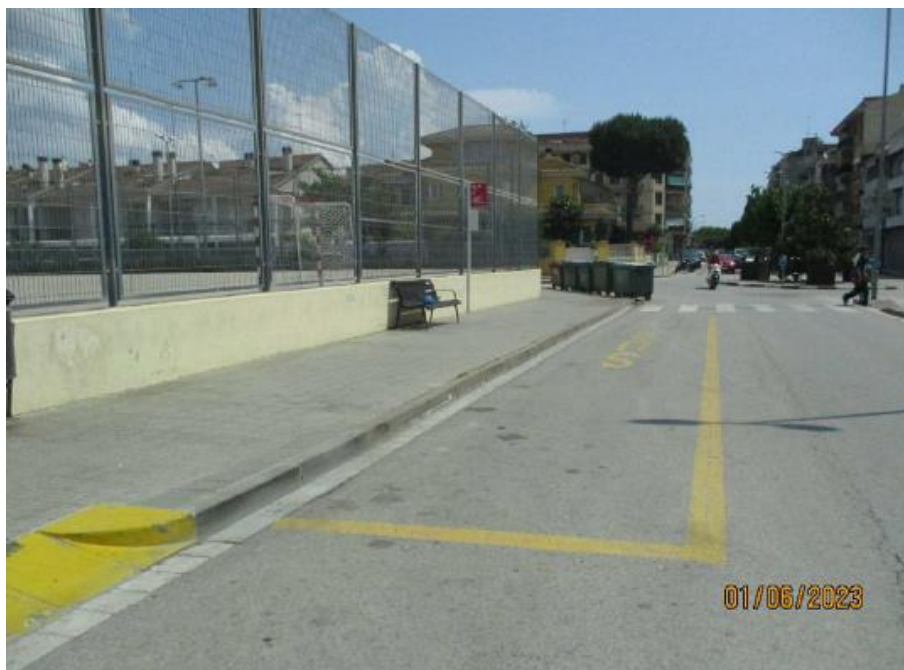
Figura 1. Imagen del Estado Actual de la Parada M23.
