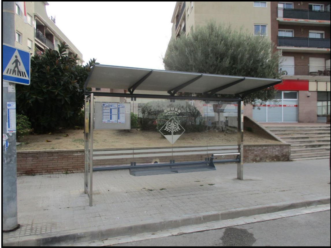
Figura 2. Parada de Autobús en Carrer Garbí con Passeig Costa Brava - Benzinera, Estado Actual.
