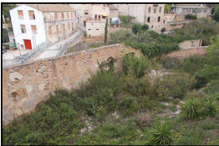
Vista des del carrer posterior de l'estat del jardí interior de la Casa Creus
