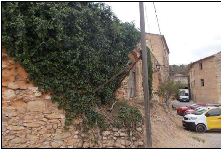
L'accés des de la façana principal al jardí interior de la Casa Creus queda elevat respecte a la rasant del carrer actual
