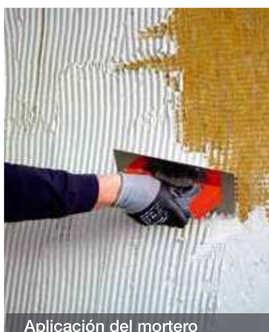
Colocación de la malla
