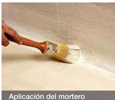
Aplicación del mortero
