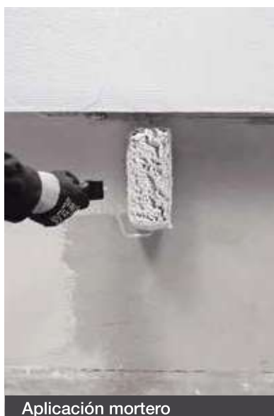
Aplicar mortero como adhesivo
