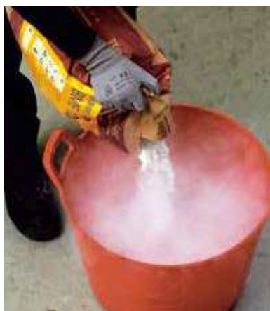
Añadir agua y mortero
