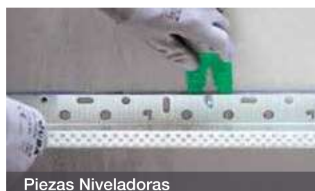
Colocar un nivel y fijar
