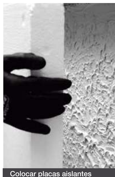
Aplicar mortero como adhesivo
