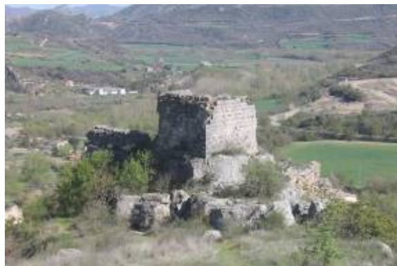
Torre situada a l'extrem meridional del recinte fortificat
