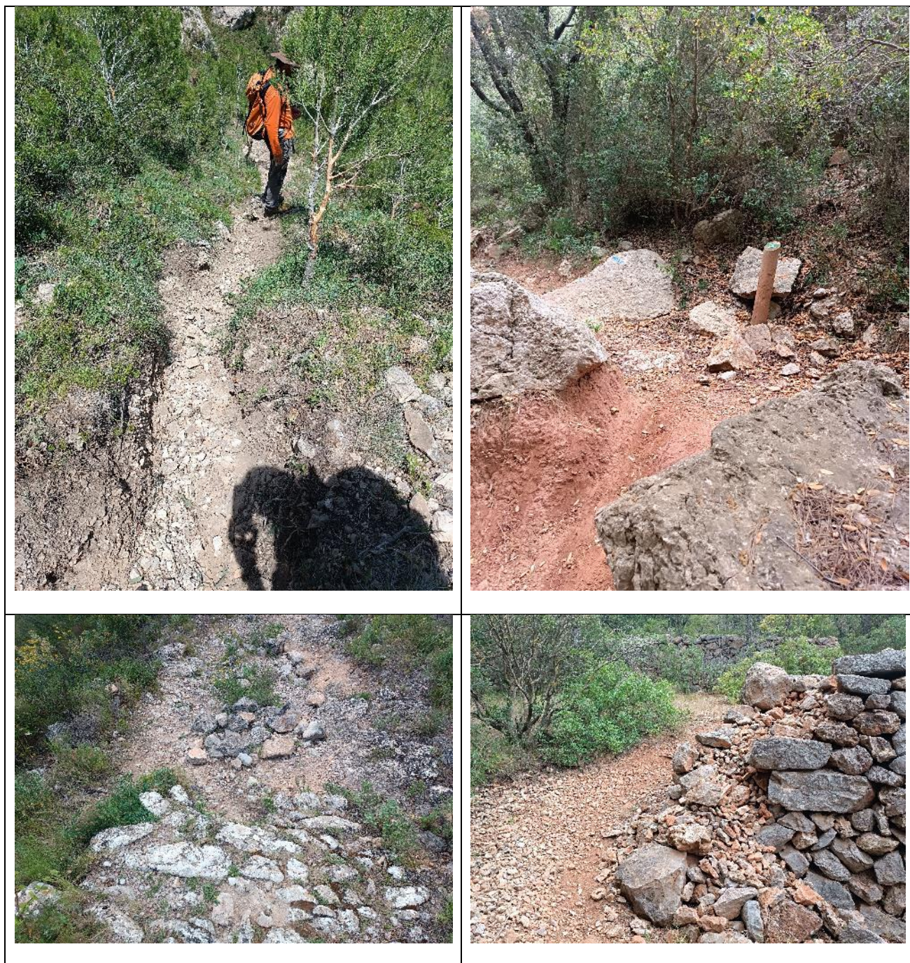
Figura 15 Imatges a baix: erosió per pas de bestiar i senderistes (esquerra) i motocicletes (dreta) a Baix: exemple de desacoblament d'empedrat (esquerre) o caiguda de marge sobre plataforma per erosió derivada del pas motoritzat (dreta)
