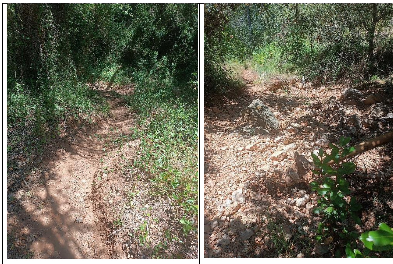
Figura 38 Imatges del tram del camí erosionat pel pas de motocicletes i el sector del barranc.
