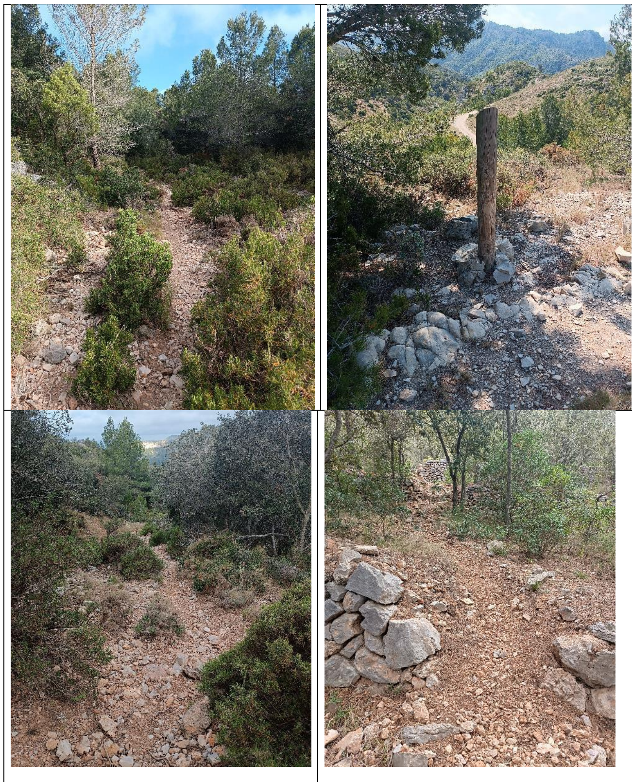
Figura 14 Imatges Dalt: exemples de tancament de la vegetació, sense un camí principal definit, Baix: pedruscall en diferents nivells de degradació, amb caiguda puntual de marges per la pèrdua de plataforma.
