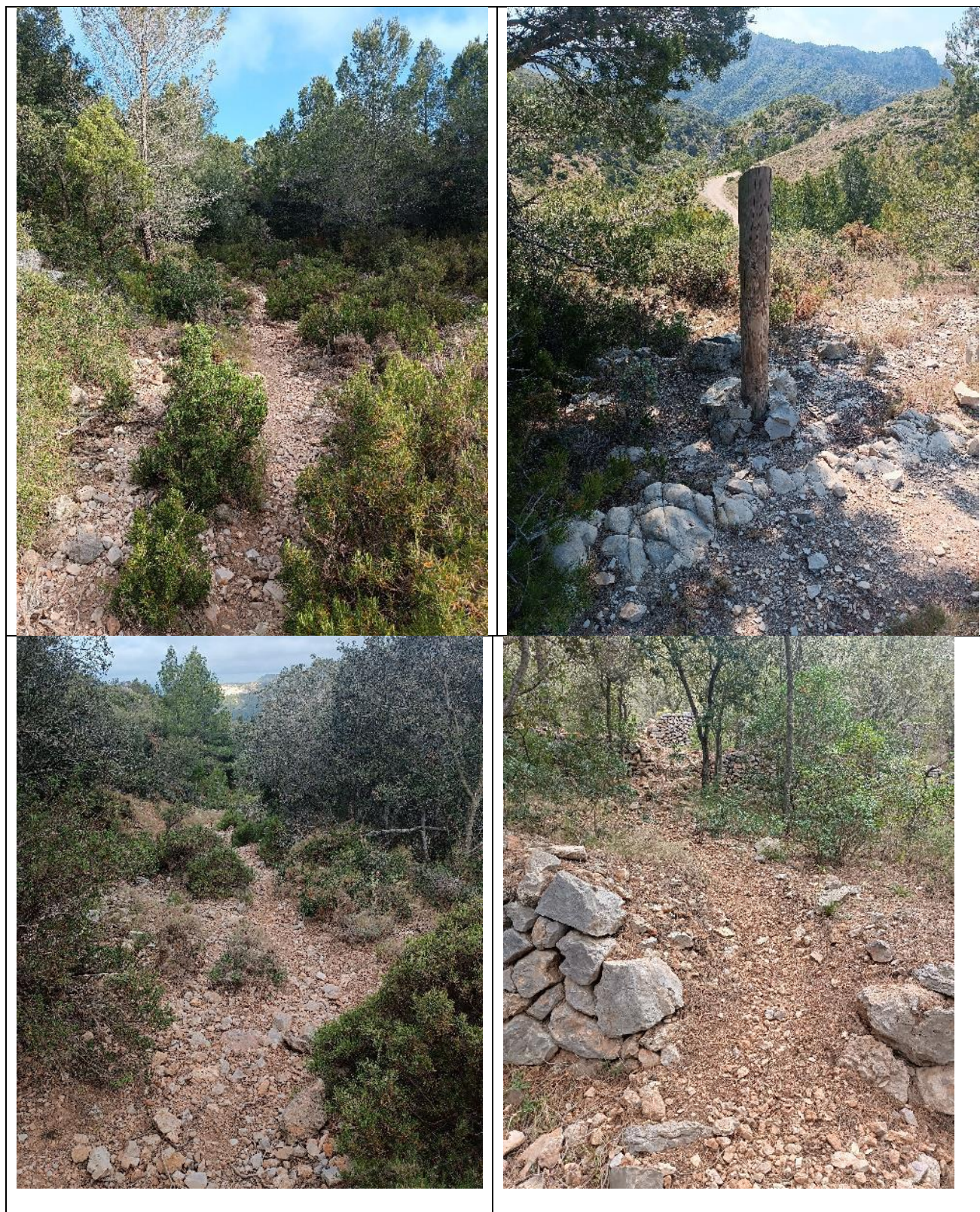
Figura 12 Imatges Dalt: exemples de tancament de la vegetació, sense un camí principal definit, Baix: pedruscall en diferents nivells de degradació, amb caiguda puntual de marges per la pèrdua de plataforma..
