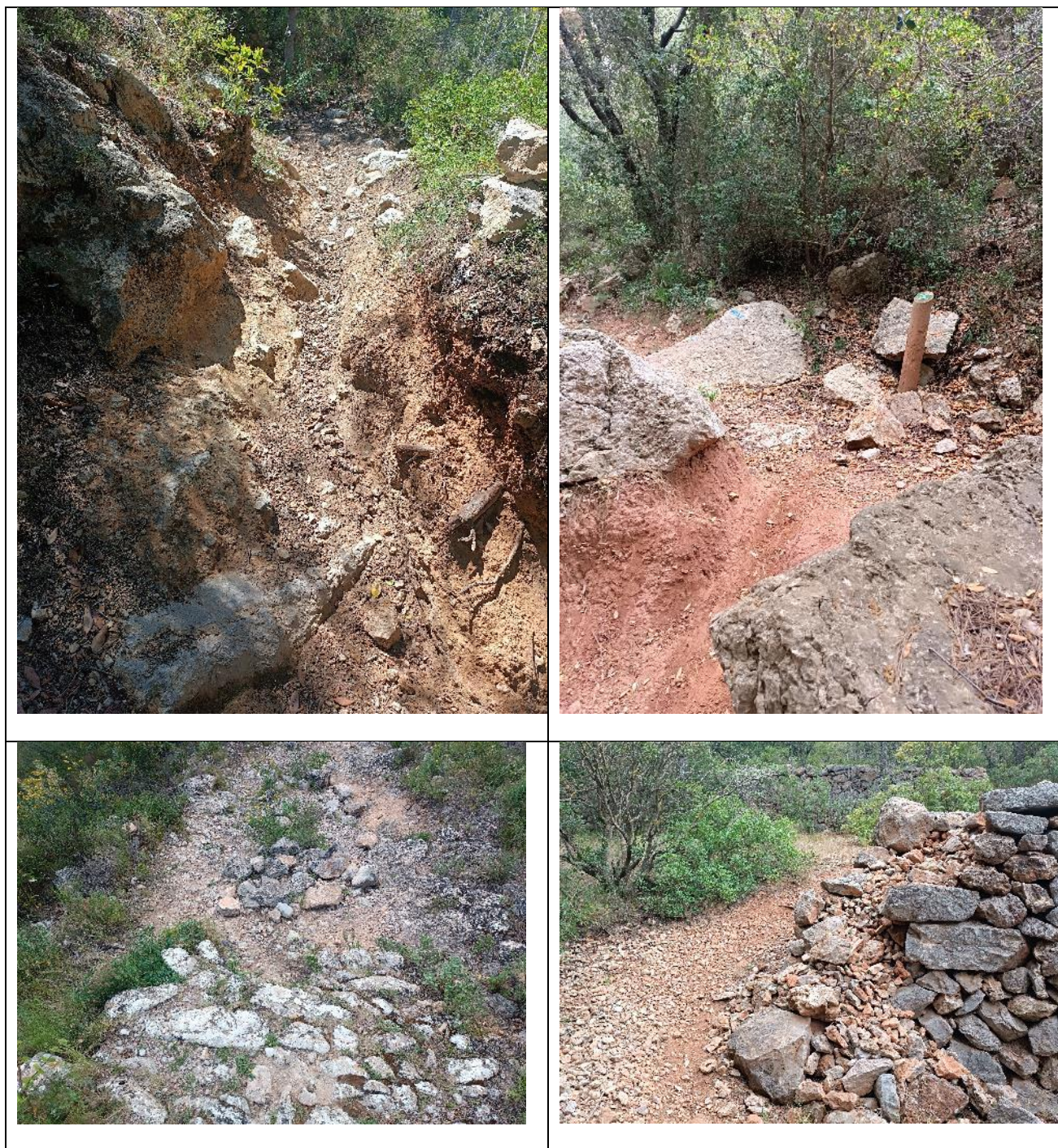
Figura 13 Imatges a baix: erosió per pas de motocicletes (dreta) a Baix: exemple de desacoblament d'empedrat (esquerre) o caiguda de marge sobre plataforma per erosió derivada del pas motoritzat (dreta)
