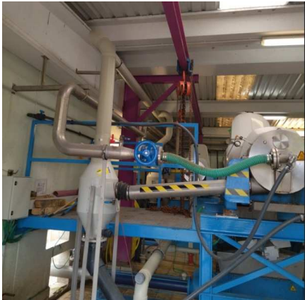
Connexions aspiracions aire conductes centrifuga
