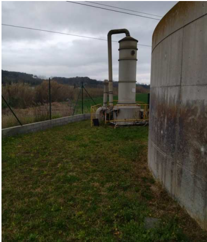
Vista general tub aire fins a desodoritzador a substituir
