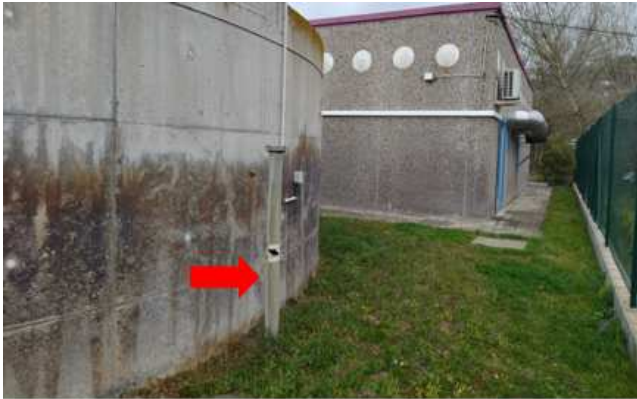
Tub aire aspiració per l'esspessidor existent
