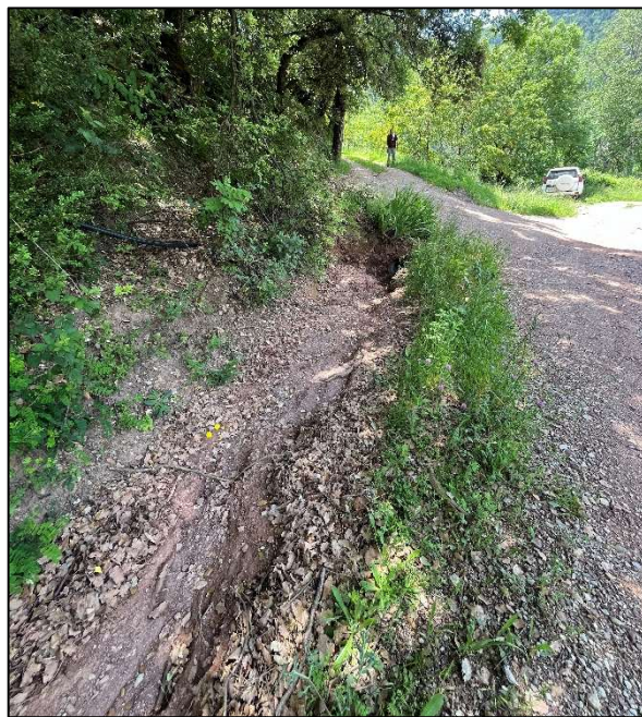
Foto 12: Tub a l'entrada d'un camí amb un tram de cuneta que canalitza l'aigua del camí en un tram de 30 m (Font: Montserrat Solanelles Ubach).
