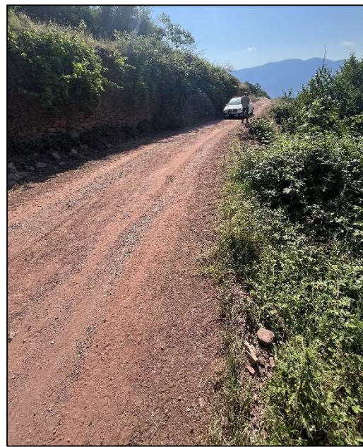
Foto 8: Tram de la borda del Pubill amb amplada de la pista de 3 m i paret de pedra seca al talús superior (Font: Montserrat Solanelles Ubach).
