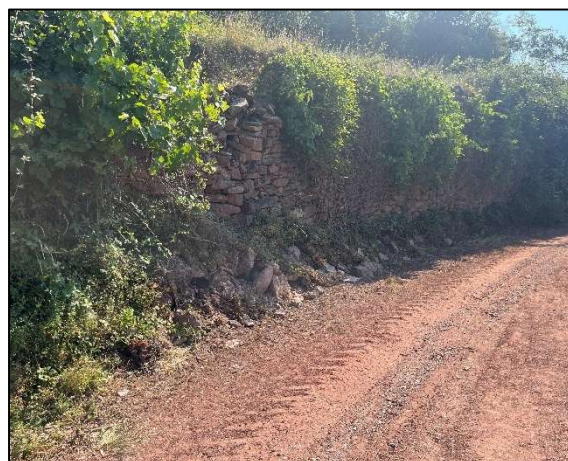
Foto 23: Paret de pedra seca, vertical en el talús superior (Font: Montserrat Solanelles Ubach).
