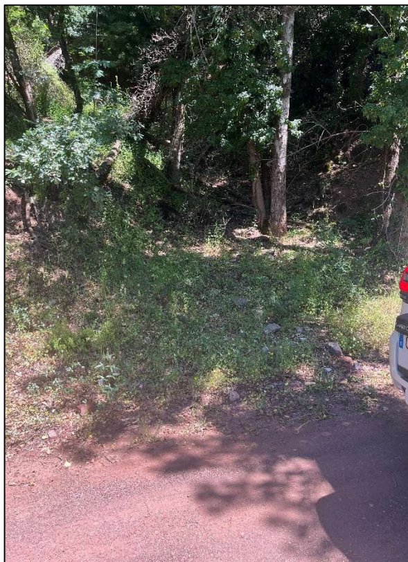
Foto 15: Creuament de la pista amb el torrent a on no existeix una obra de drenatge transversal (Font: Montserrat Solanelles Ubach).
