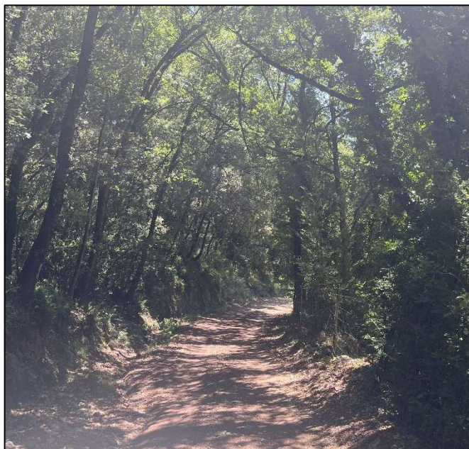
Foto 7: La vegetació envaeix la caixa del camí (Font: Montserrat Solanelles Ubach).
