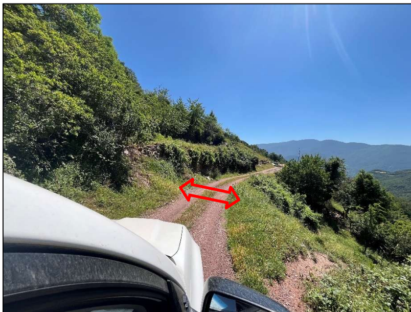
Foto 17: Creuament de la pista amb el torrent a on no existeix una obra de drenatge transversal (Font: Montserrat Solanelles Ubach).
