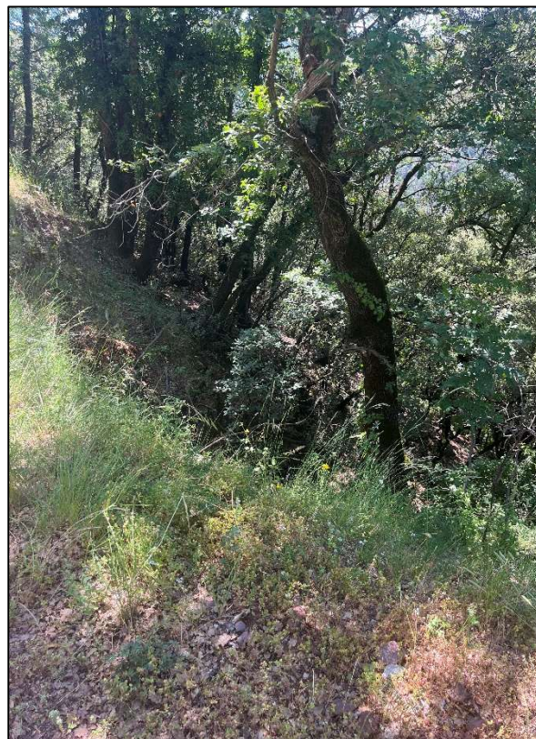
Foto 16: Talús inferior alt i erosionat (Font: Montserrat Solanelles Ubach).
