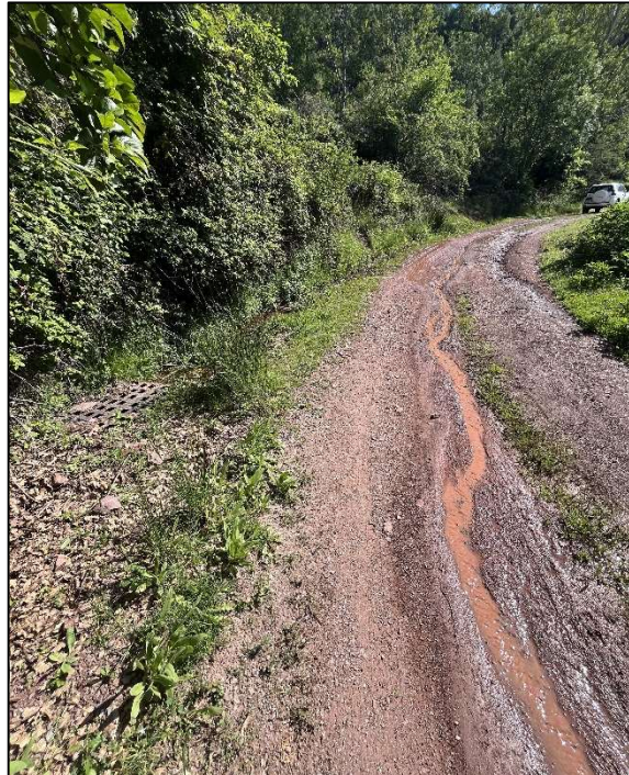
Foto 6: Tram a on l'aigua de reg circula per la plataforma generant reguerots (Font: Montserrat Solanelles Ubach).
