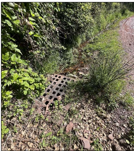
Foto 2: Cuneta amb l'aigua del reg i arqueta d'entrada d'una obra de drenatge que porta aquesta aigua al torrent (Font: Montserrat Solanelles Ubach).
