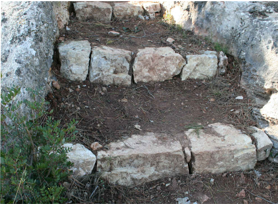
Imatges d'esglaons de pedra collada executats per NATURALEA
