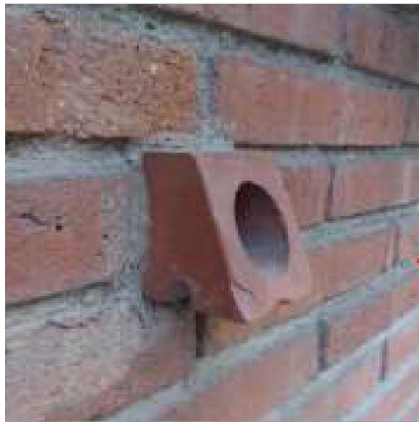
Model broc ceràmic per a fonts d'aigua de surgència natural
