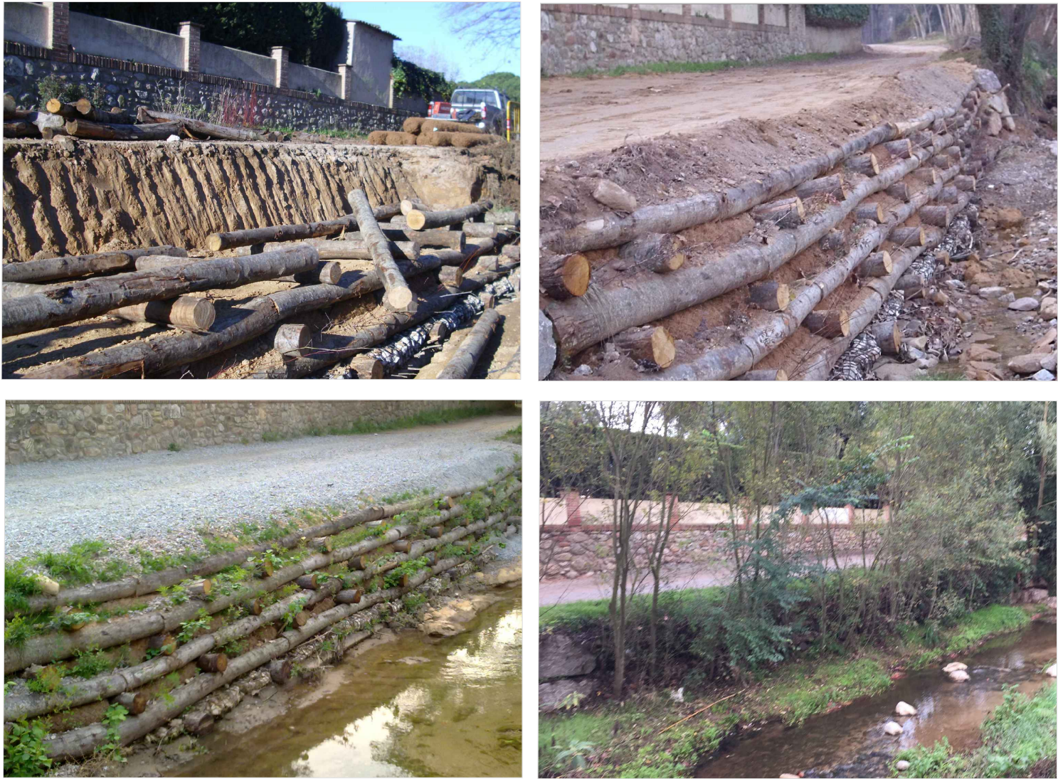
Imatges d'entramat executat per NATURALEA
