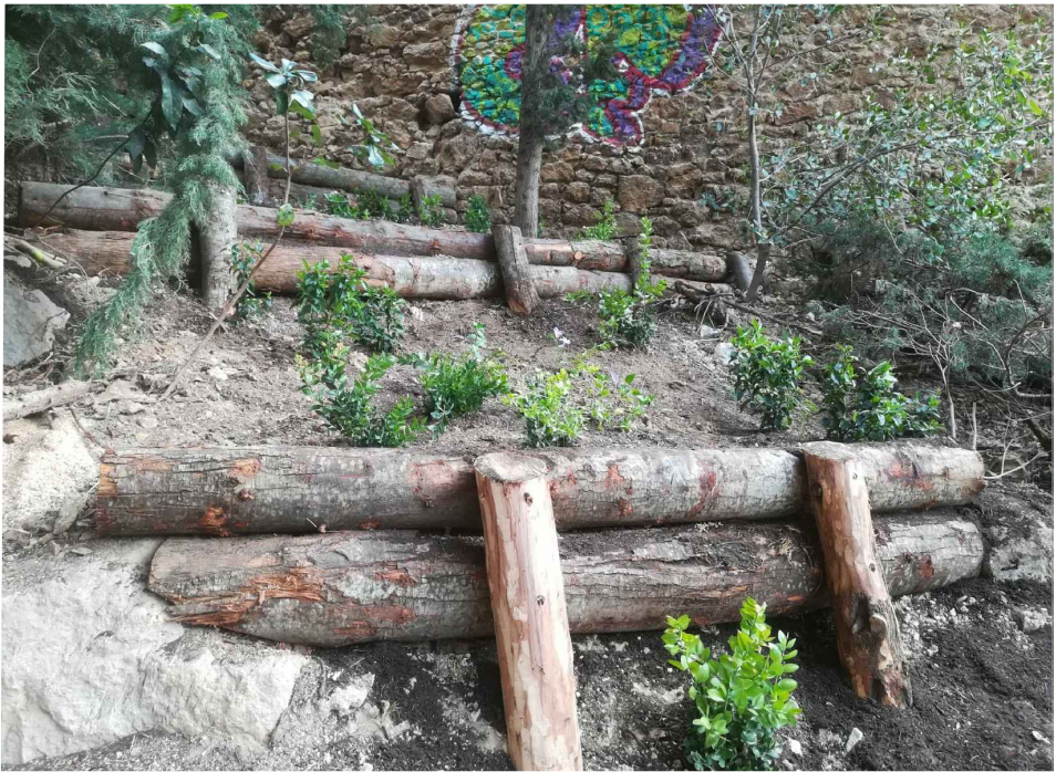
Imatges de palissades executades per NATURALEA
