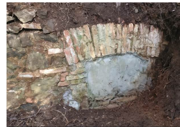
Entrada a la mina
