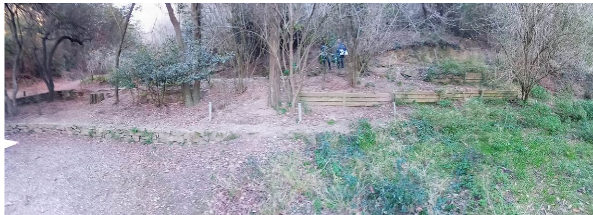
Estructures de fusta a substituir
