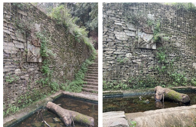
Mur de gabions construït l'any 1986 amb l'escut nou de Barcelona d'Antoni Tàpies
