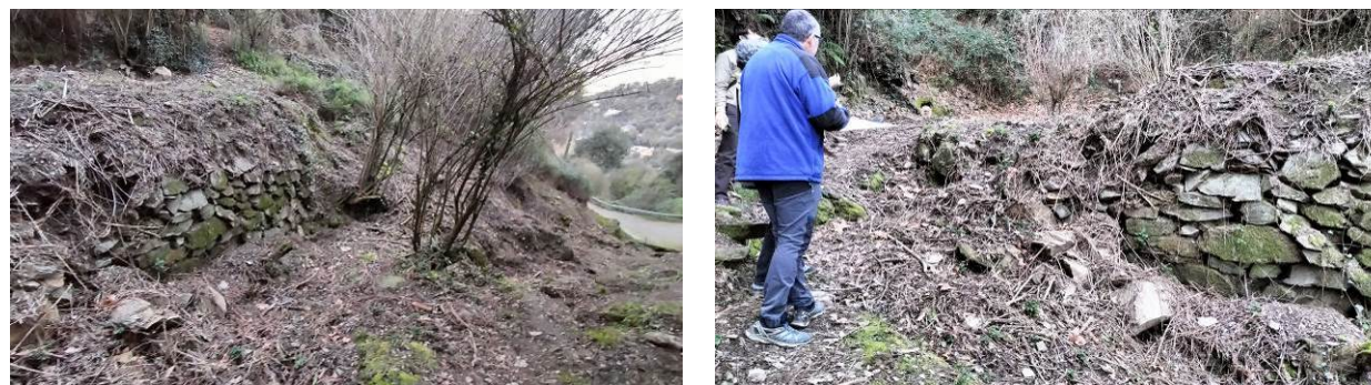
Mur a restaurar i adequar espai pel pas del torrent
