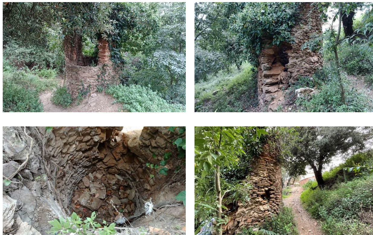
Figura 12. Pou a restaurar
