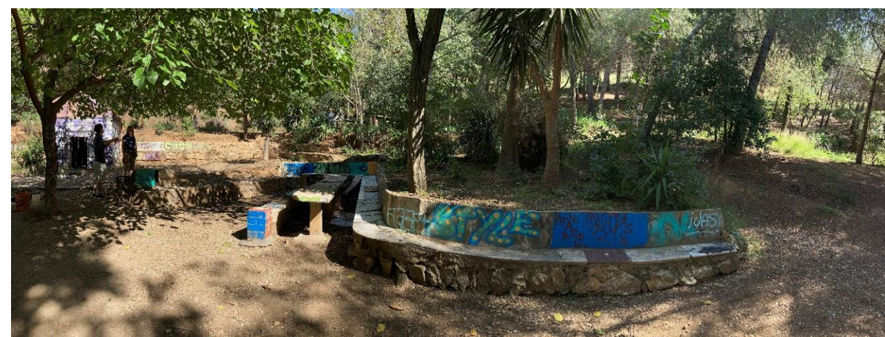
Taula i murs a enderrocar parcialment
