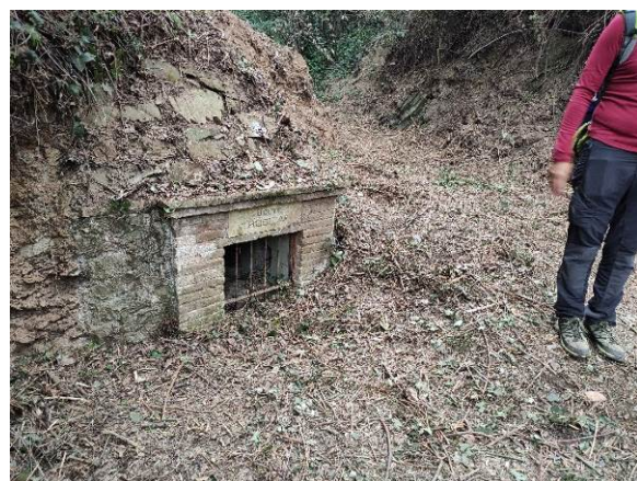
Boca de la mina amb l'acumulació de terres davant de la mina
