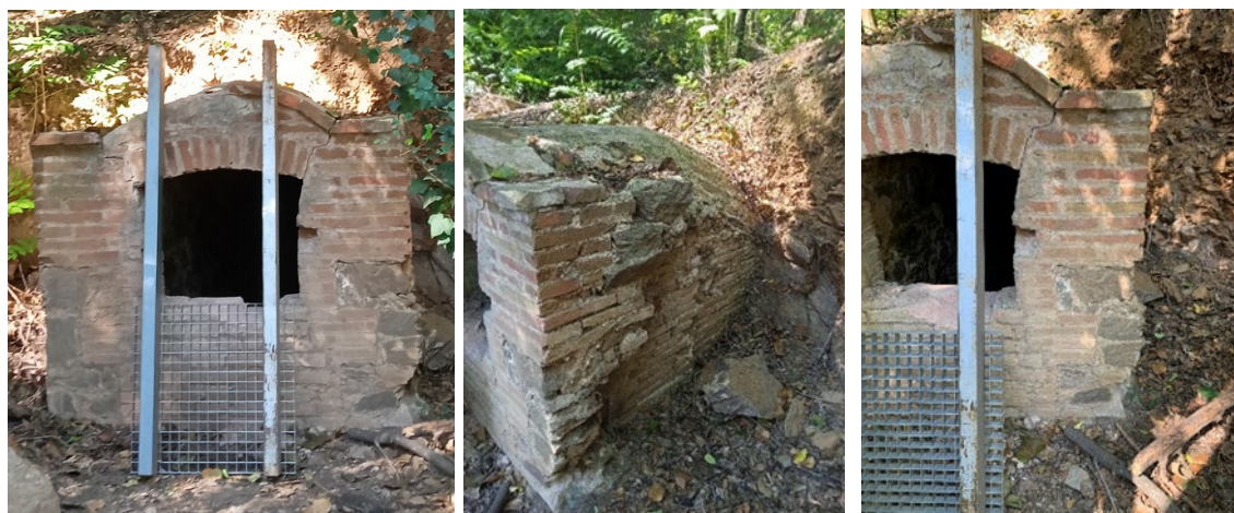
Caseta d'accés a la mina
