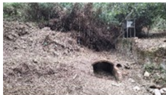
Dipòsit a restaurar
