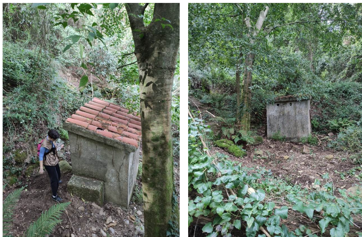
Figura 3. Caseta de l'antic sistema de bombeig, a enderrocar
