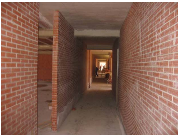
Imatges del procés d'execució de les compartimentacions interiors. Font PNA-02424-OE
