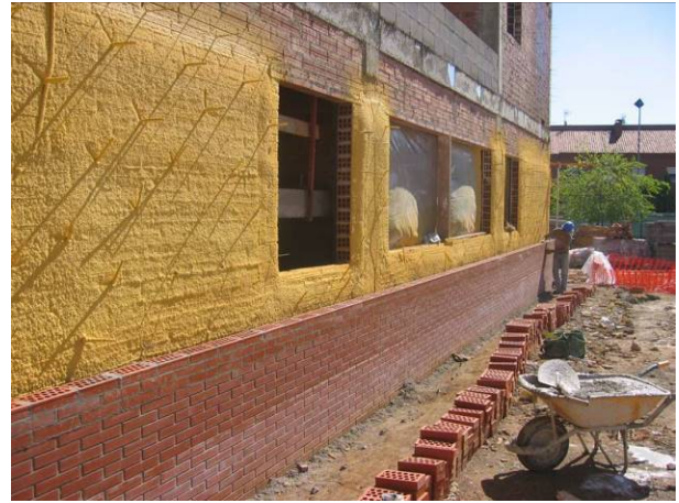
Imatges del procés d'execució dels fulls del sistema envoltent. Font PNA-02424-OE
