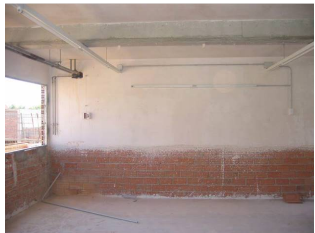
Imatges del procés d'execució de les compartimentacions interiors. Font PNA-02424-OE
