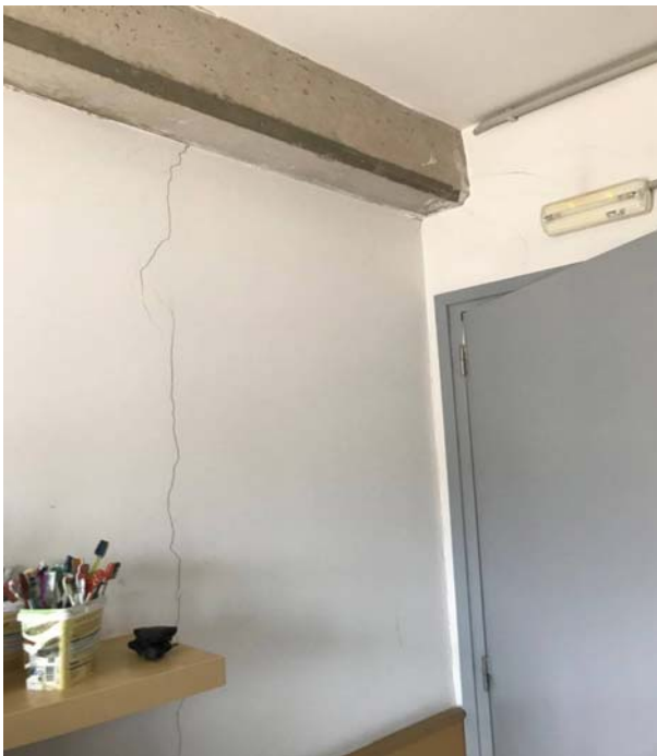
Imatges d'esquerdres per deformacions estructurals
