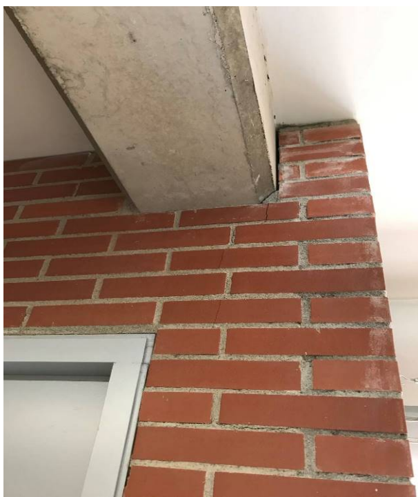
Imatges d'esquerdes per compressió de l'estructura
