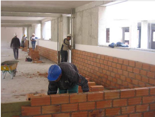
Imatges del procés d'execució dels fulls del sistema envoltent. Font PNA-02424-OE
