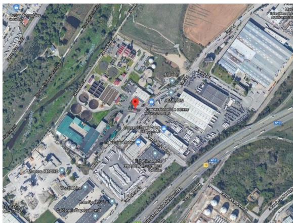
Figura 1. Vista aèria del CCTRVO (Font: Google Maps 2019)
