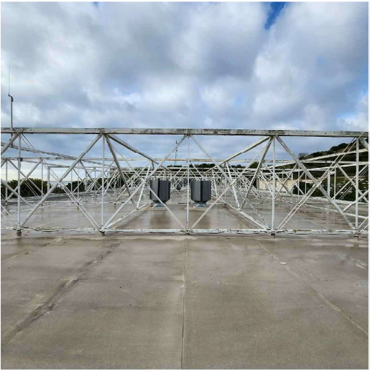
ESTRUCTURA DE L'EDIFICI
