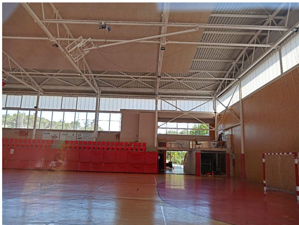
Vista inferior de la coberta amb panells de xapa grecada de la solució amb sistema sandvitx emprada. Vista de l'estructura metàl·lica dels cavalls de coberta.
