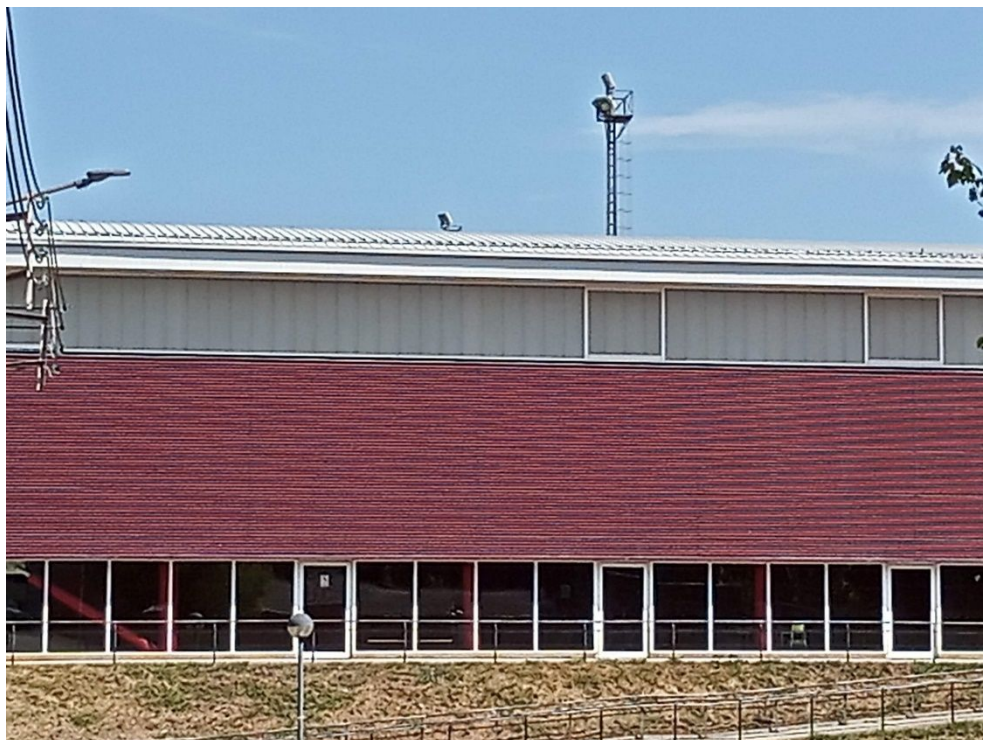
Coberta en volta amb xapa grecada superior de solució tipus sandvitx.
