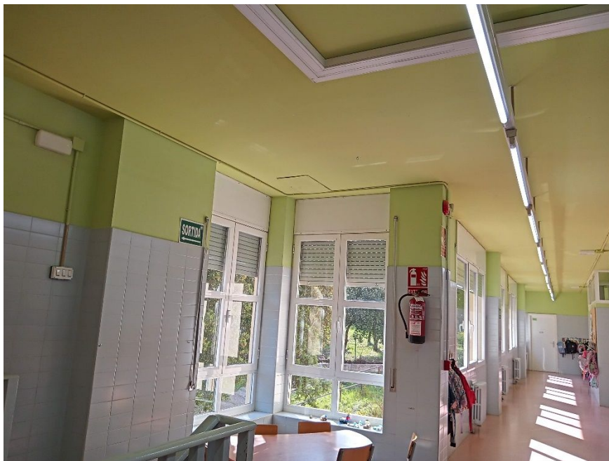
Forjat de coberta des de l'interior de l'escola, trapa d'accés a la coberta per al seu manteniment.
