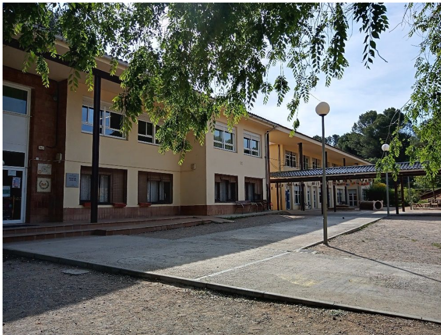
Façana al pati de fàbrica ceràmica estructurals i pòrtics metàl·lics a la porxada exterior.
