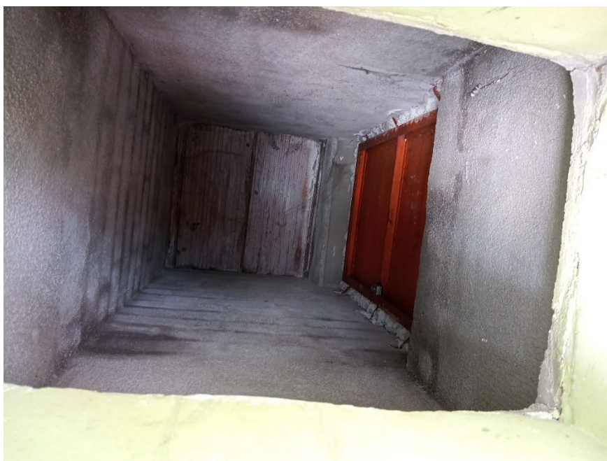
Canal vertical a través de l'espai que generen els envans conillers i porta d'accés a la coberta.
