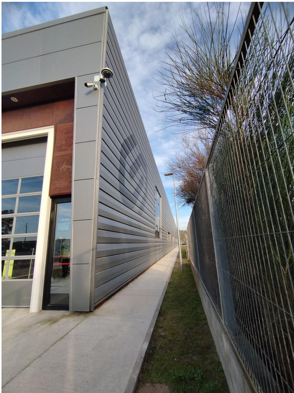
Futura localització d' INVERSORS i SCFV
