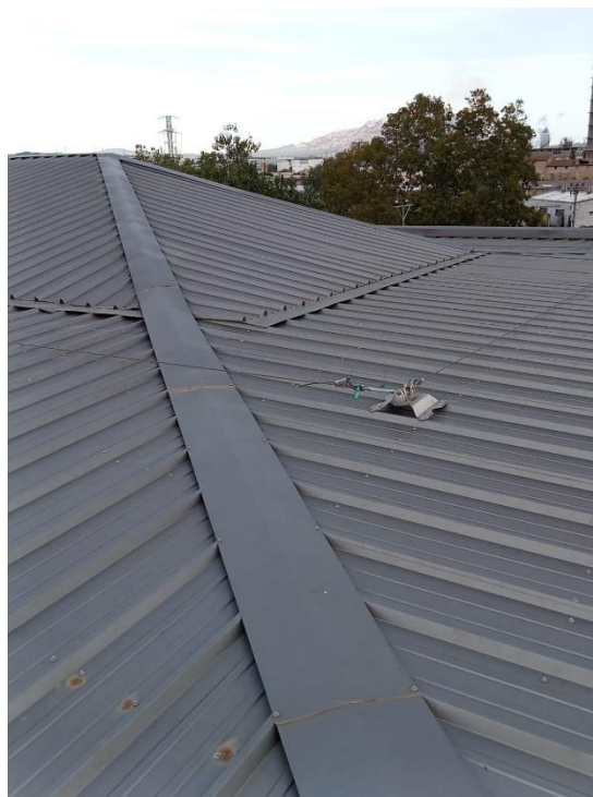
Coberta inclinada de xapa
