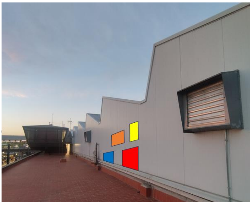
Futura localització d' INVERSORS i SCFV
