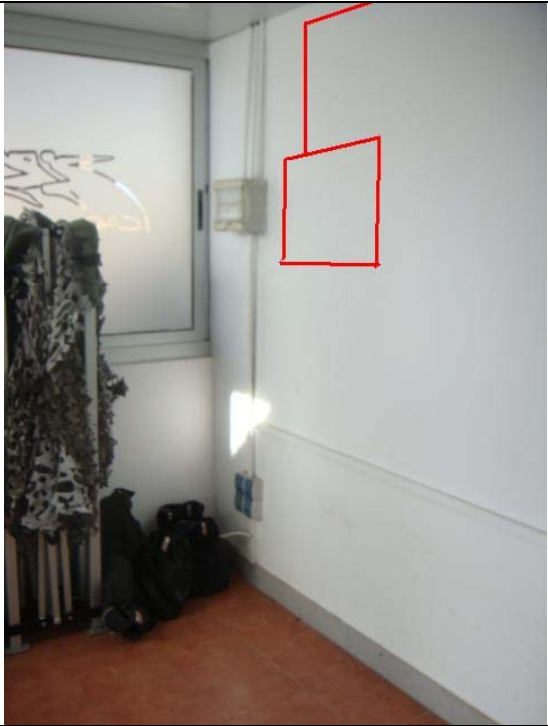
Instal·lació de rack mural i canaleta metàl·lica a l'interior de la caseta de la piscina
