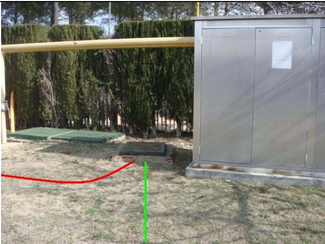
Arqueta existent 08205PE0985 on arriba la canalització existent i surt la nova canalització cap al camp de futbol
