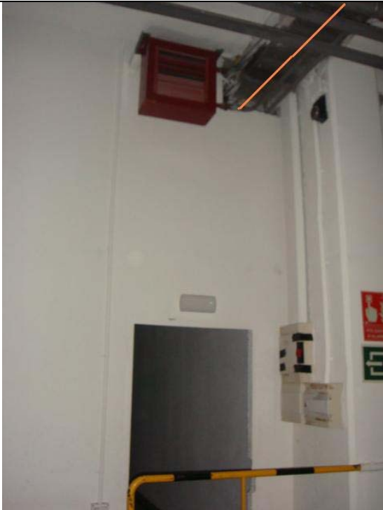
Vista 4_Pas del cable de la canaleta del passadís al fals sostre previ al gimnàs groc
