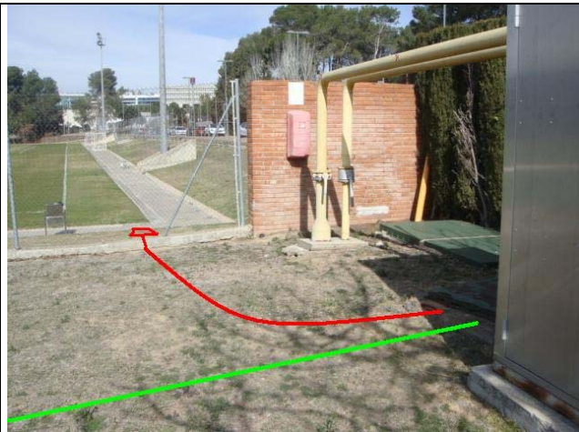
Arqueta existent 08205PE0985 on arriba la canalització existent i surt la nova canalització cap al 1er armari del camp de futbol
