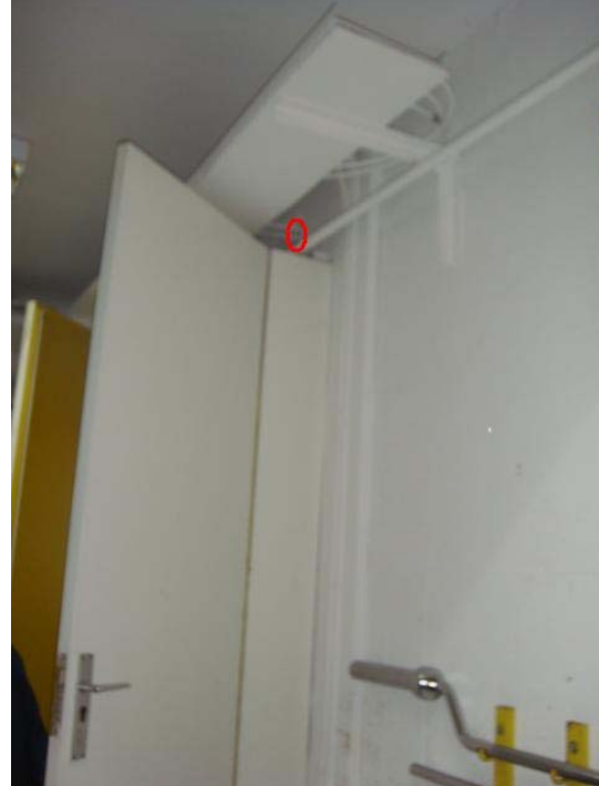
Vista 6_Sortida del gimnàs per nou passa murs fins a arqueta exterior 08205PE0984
