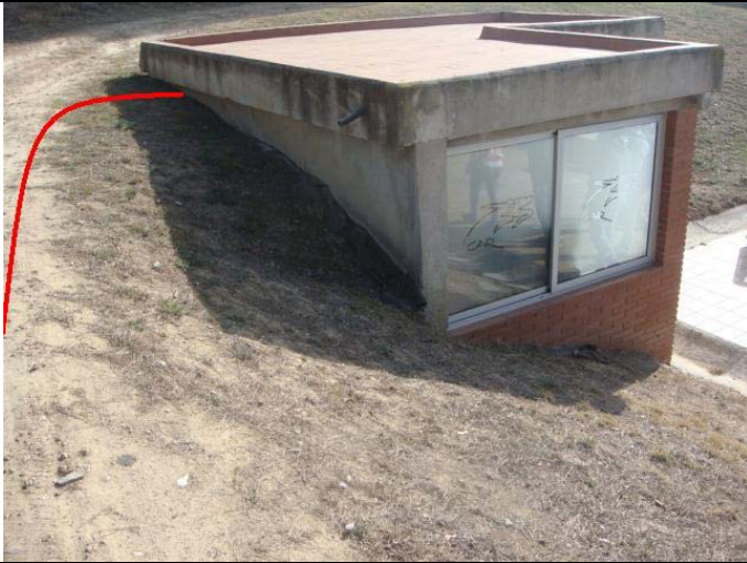
Canalització fins a la part posterior de la caseta de la piscina i passa-mur d'accés a l'interior
