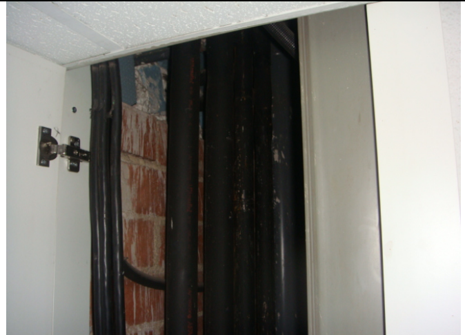
Interior del muntant de serveis de l'edifici de la Residència per pujar fins la 3ª planta
