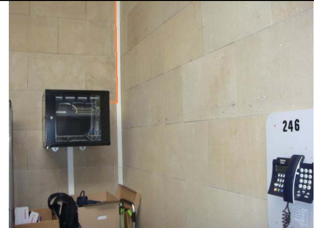
Vista 4_Traçat interior fins armari rack existent a la recepció del pavelló de gimnàstica (08205RK01LC4040)
