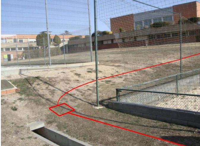
Ubicació de l'armari d'exterior entre les dues pistes de volei i futbol platja. Sortida per la part superior de la canalització de previsió elèctrica
