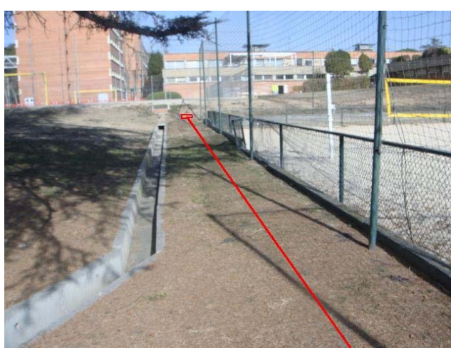
Canalització pel lateral de la pista de volei-platja fins al nou armari
