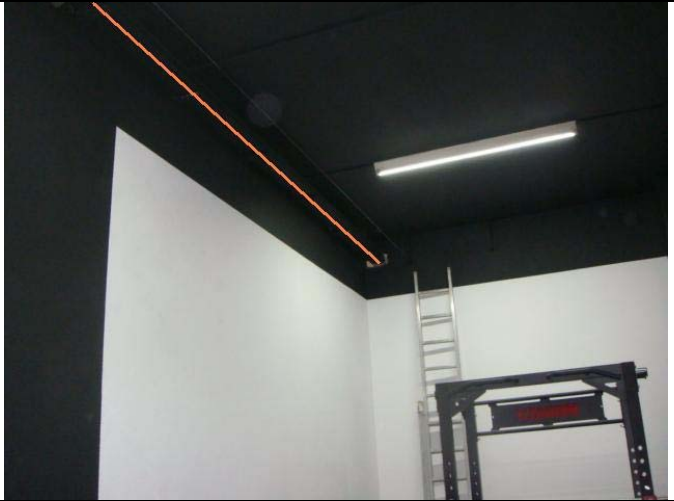
Vista 2_Estesa del cable per les canaletes del gimnàs
