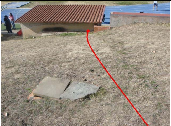
Canalització fins a la caseta de la pista d'atletisme i entrada amb passa-murs per la paret posterior
