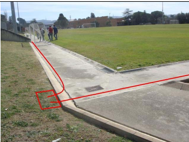
Situació del tercer armari 08205RK01LC4049
