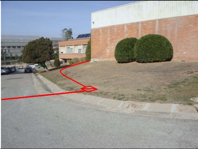
Pericó 08205PE0976 i creuament del vial asfaltat cap al pericó existent 08205PE0459
