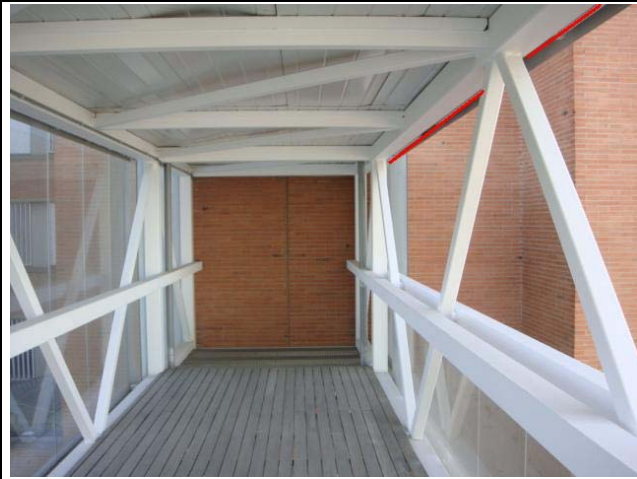
S'instal·larà un tub metàl·lic de D48mm fixat a l'estructura metàl·lica de la passera
