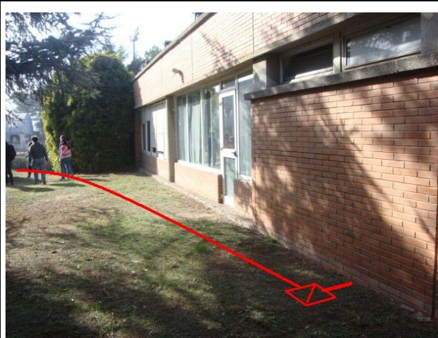
Pericó 08205PE0975 a l'exterior de l'Institut i canalització per terres
