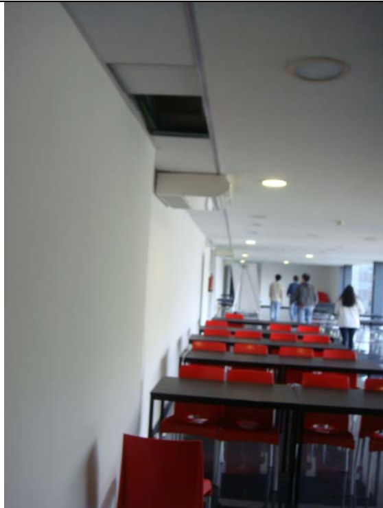
Vista 7_Canaletes al fals sostre de les sales de l'edifici del CPD
