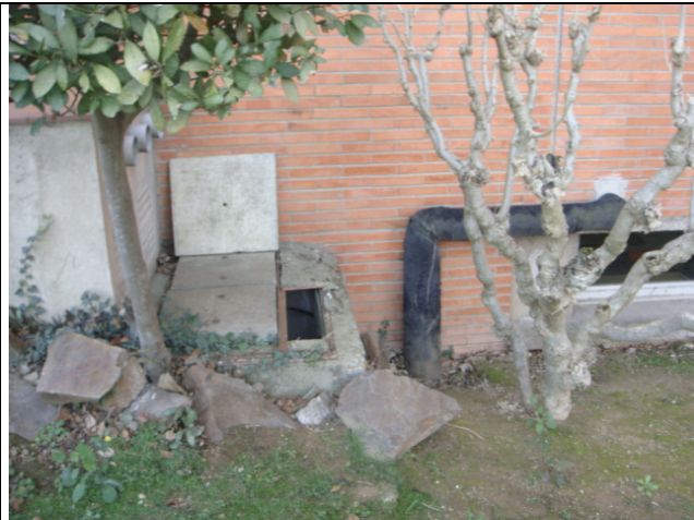
Arqueta existent 08205PE0984 a l'exterior de l'edifici
