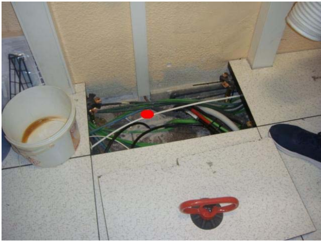
Vista 1_Terra tècnic de la sala CPD amb el passa forjats al gimnàs de la planta inferior
