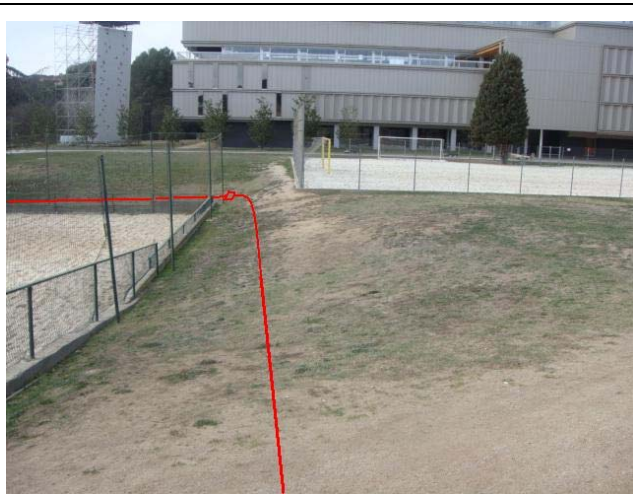
Canalització elèctrica des de l'armari cap a l'edifici
