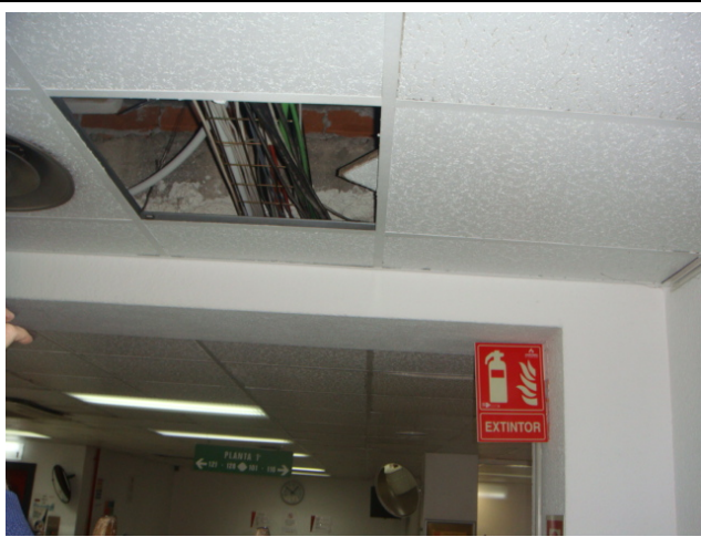
Canaletes existents al fals sostre de l'edifici de la Residència
