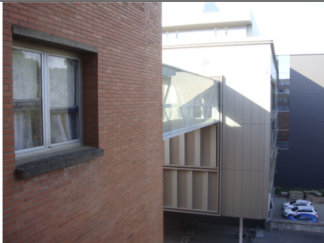
Passera elevada que uneix la Residència amb l'edifici del CPD
