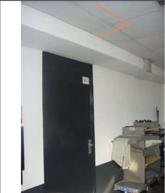
Vista 3_Traçat per canaleta del fals sostre entrant a l'habitació nº 300 a la 3ª planta
