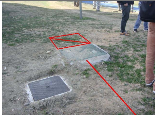
Pericó existent 08205PE0459, actualment tipus B i que s'haurà d'ampliar a tipus C
