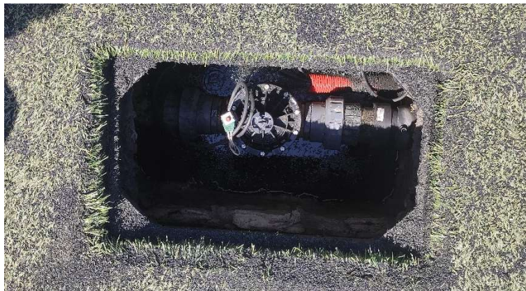
Detall d'una aspersor i l'electrovàlvula
