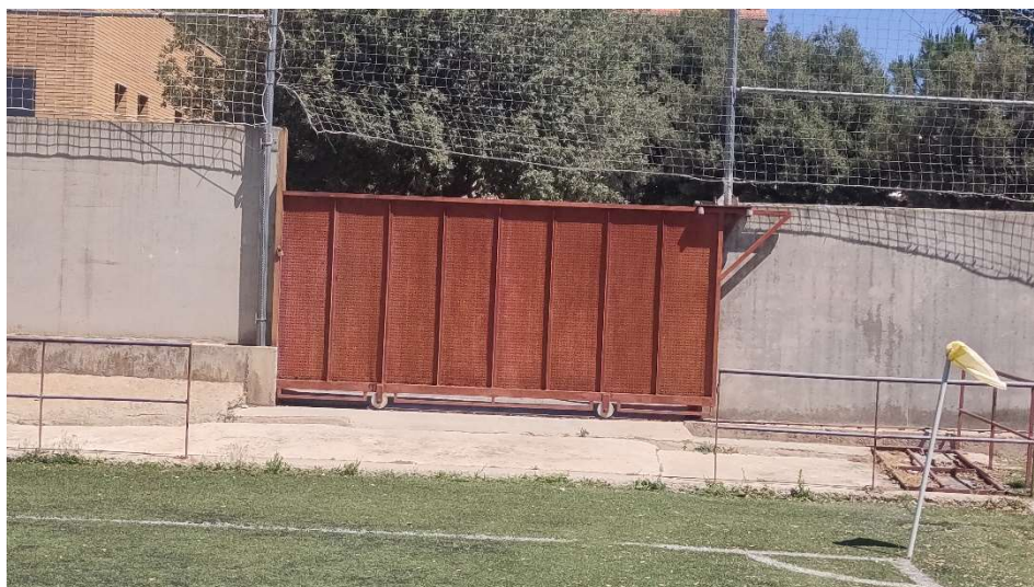
Vista de la porta d'accés per a vehicles durant les obres
