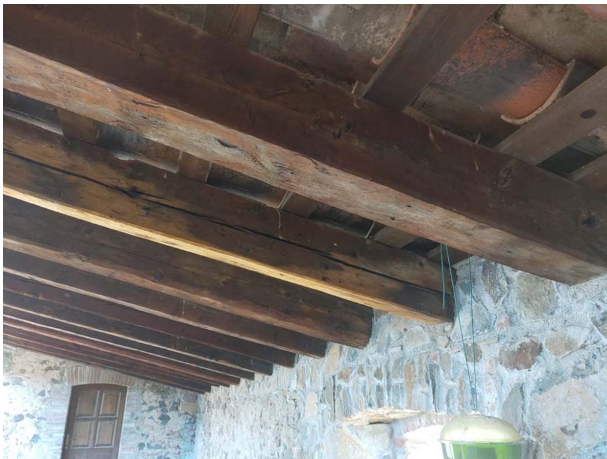
Detall de les bigues del porxo de l'annex nord
