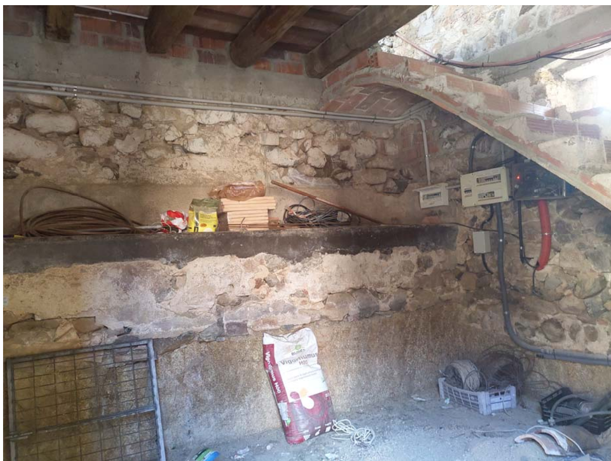
Cambrà 1 de la planta baixa de l'annex nord
