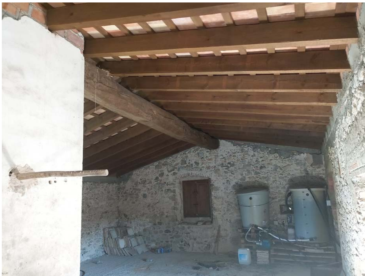
Zona on s'ubiquen els dipòsits d'aigua a la planta pis de l'annex oest
