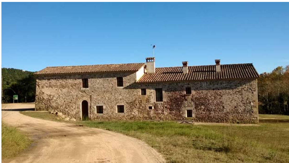
Façana oest des del camí d'accés
