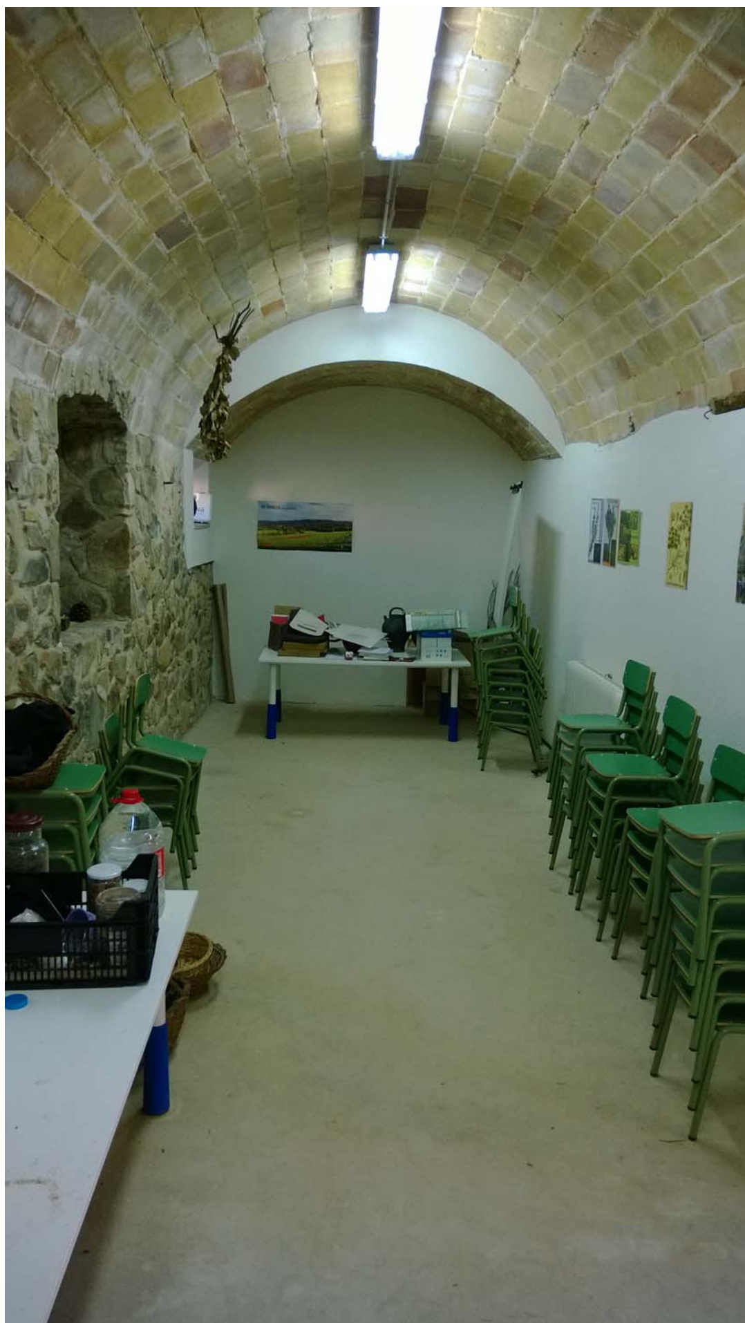
Sala 1 en planta baixa de l'annex oest, amb la volta de maó
