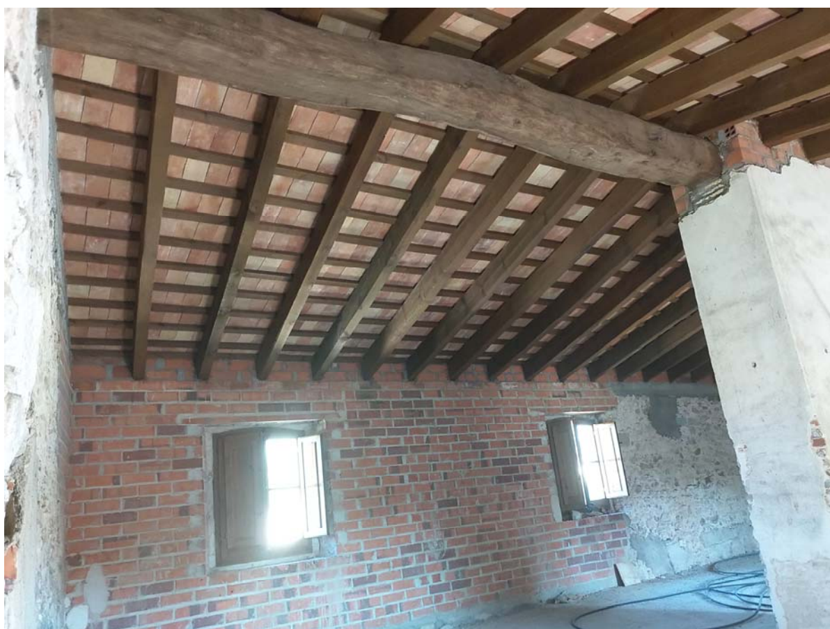
Detall de la coberta de l'annex oest
