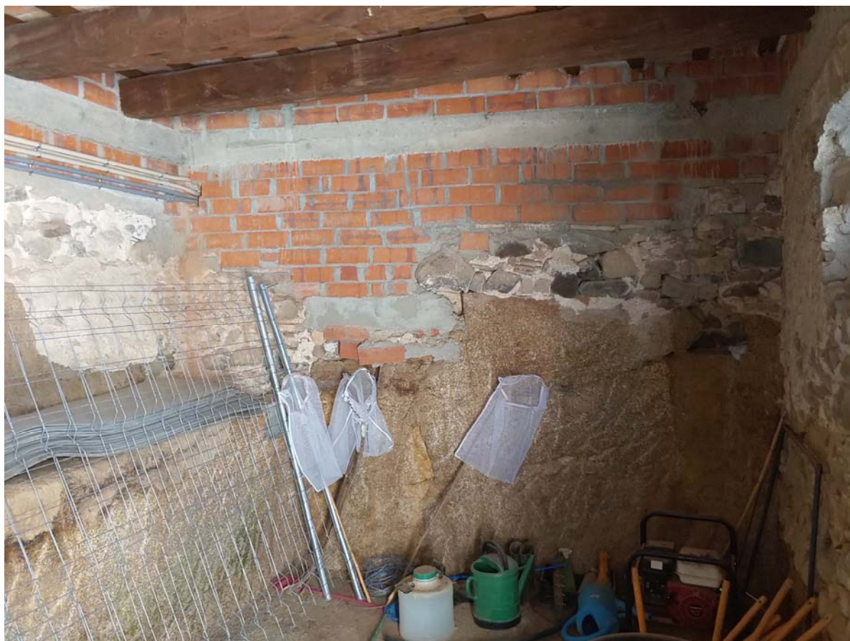
Cambrà 2 de la planta baixa de l'annex nord
