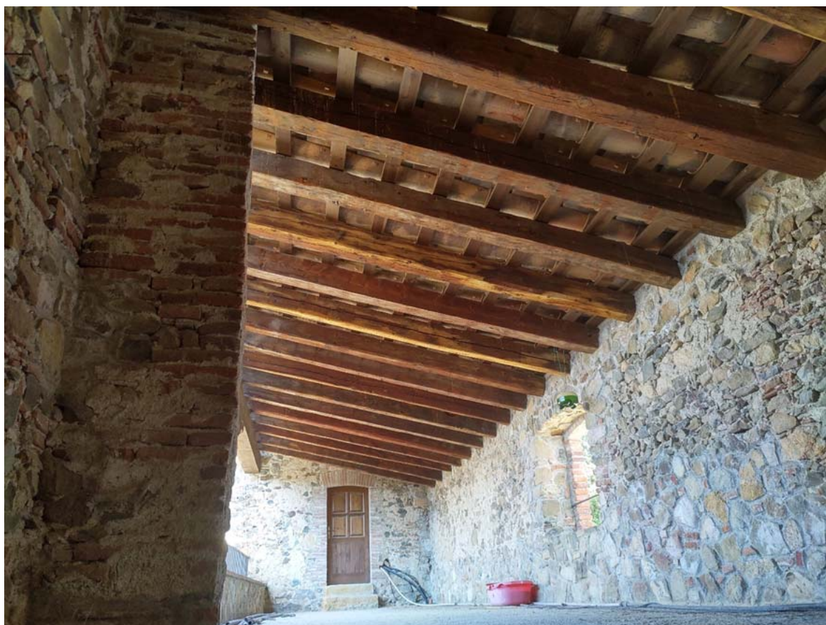
Porxo de la planta pis de l'annex nord
