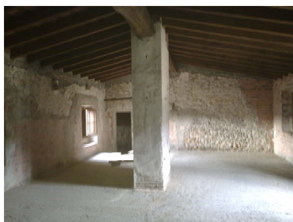
Annex posterior on s'ubica la sala polivalent
