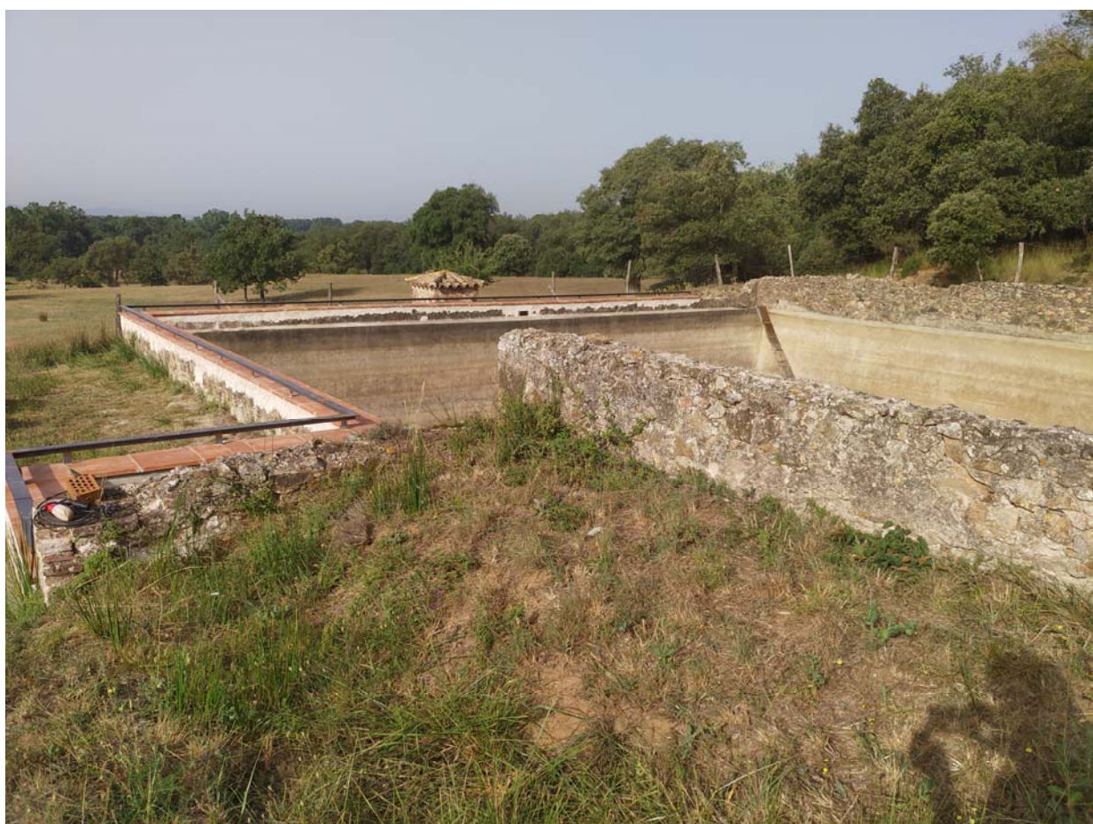
Bassa del sistema de magatzematge d'aigua de la finca, a tocar l'edifici de Can Vilallonga
