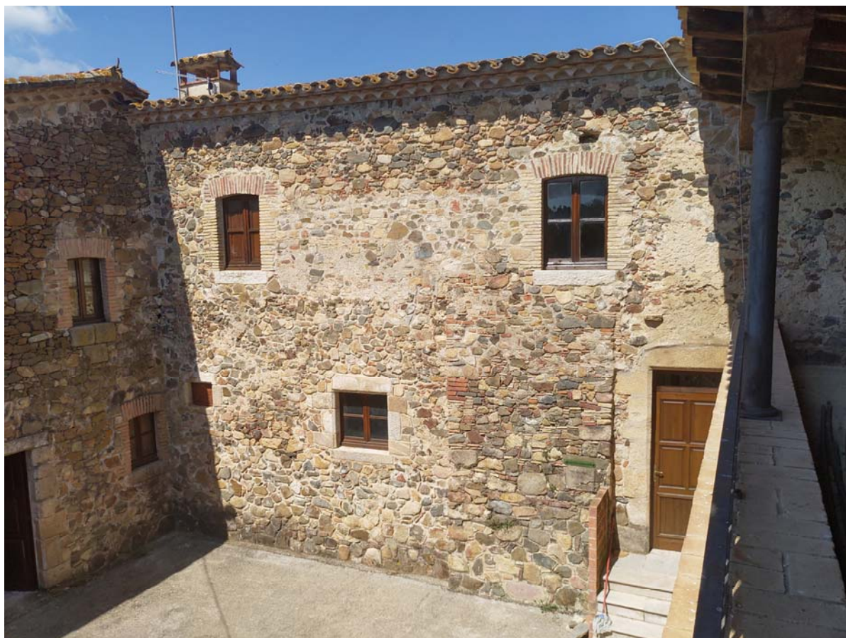
Façana a pati de l'annex oest
