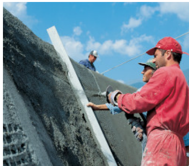
Aplicación de Mapegrout T40 SR con máquina de revocar
