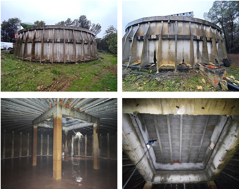
Fotografies identificatives del dipòsit DIPÒSIT NOU (fotografies de novembre del 2021)
