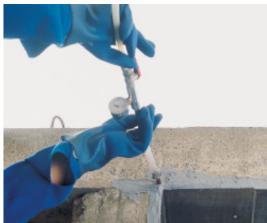
Viga placada con Adesilex PG1
