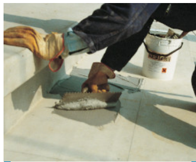
Aplicación mediante llana dentada de Adesilex PG1 para el encolado estructural de peldaños prefabricados
