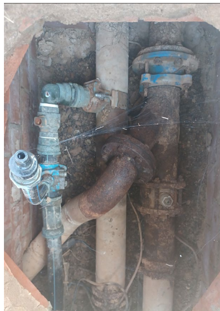
Imatge 3 i 4.- Elements hidràulics existents a l'arqueta on realitzar el bypass.
