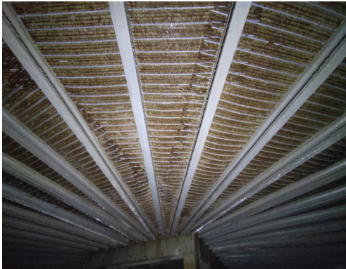
Estat de l'oxidació en tota la superfície de la malla tipus Nervometal.
