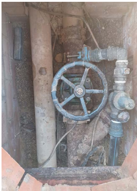
Imatge 3 i 4.- Elements hidràulics existents a l'arqueta on realitzar el bypass.
