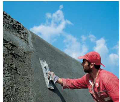
Acabado de Mapegrout T40 SR con fratas
