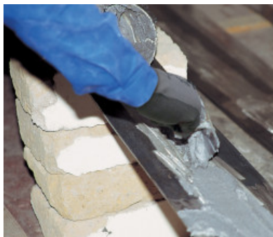
Aplicación de Adesilex PG1 sobre placa metálica
