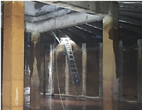
Accés a l'interior del dipòsit.
